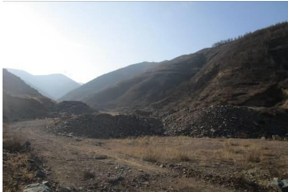
恒山隧道3号斜井弃渣场
