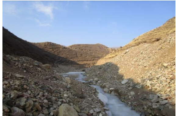
恒山隧道2号斜井弃渣场
