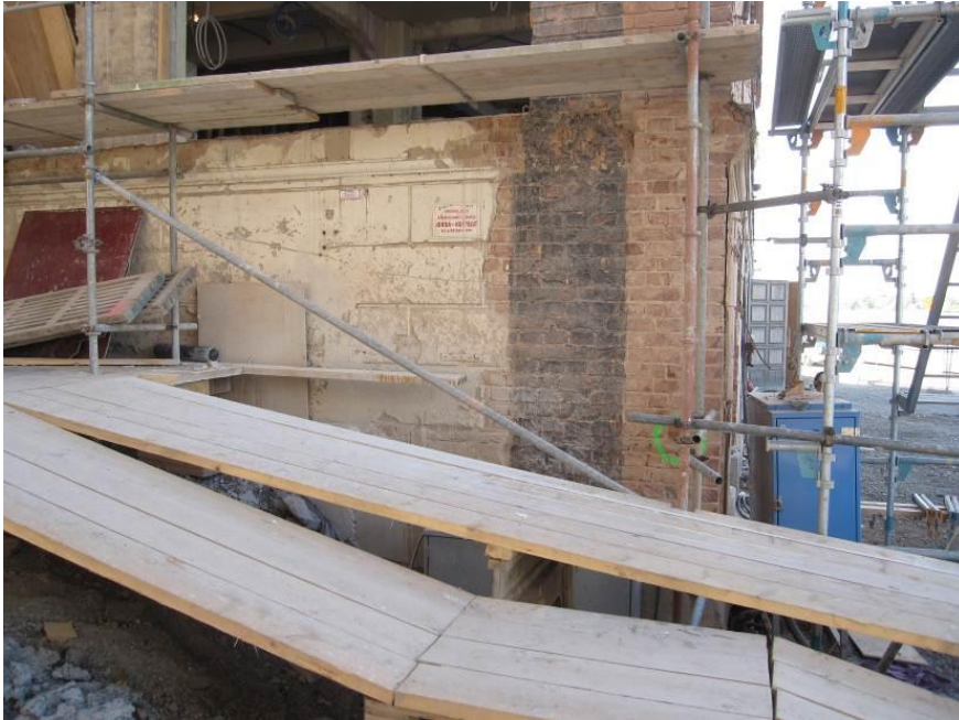
Östra fasaden efter rivning av tillbyggnad och friläggning av ursprunglig fasad.
