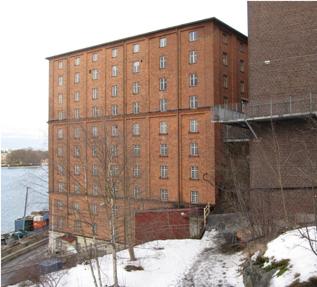
Bilden visar samma fasader som föregående foto, före rivningar och ombyggnader.
