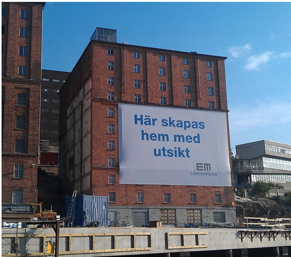
Vy från sjösidan, mot söder. Notera den lilla takpåbyggnaden för hiss och ventilation.
