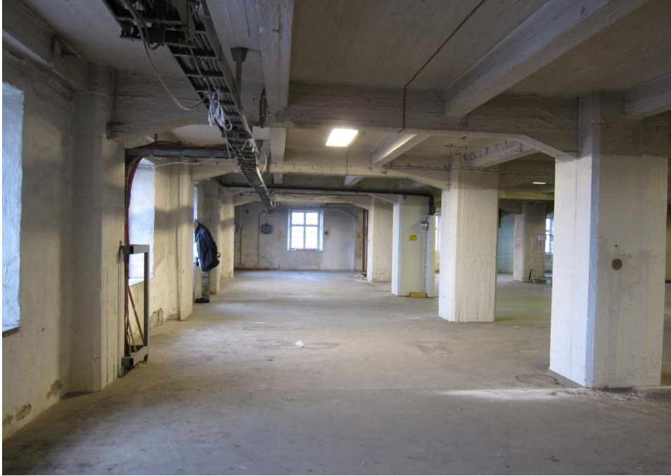
Del av öppet våningsplan innan ombyggnaderna.
