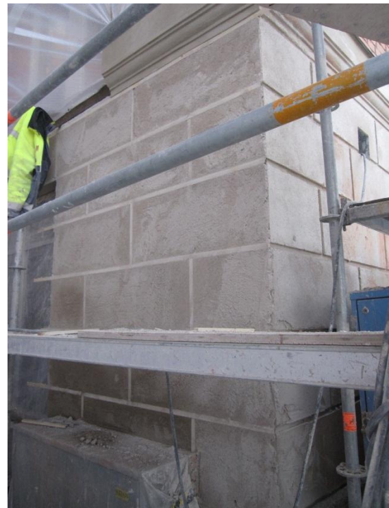
Samma hörn som ovan, under murningsarbetet, med återskapande av list mellan sockel och putsfasad.
