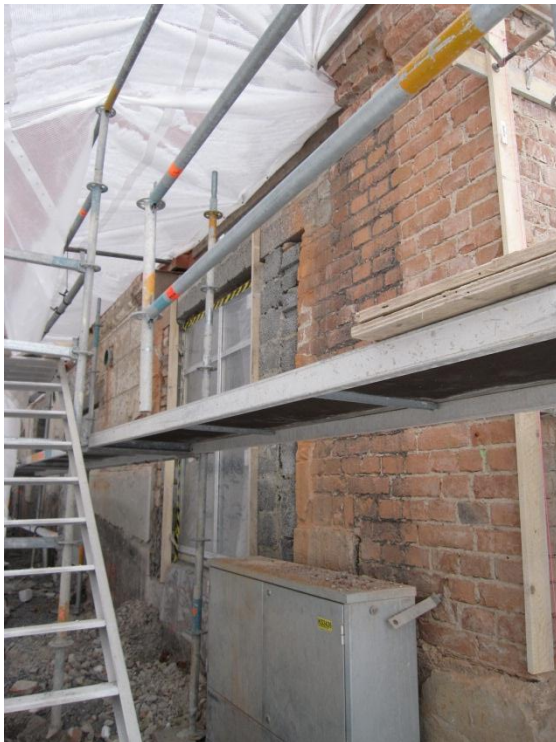
Samma hörn som ovan, under murningsarbetet, med återskapande av list mellan sockel och putsfasad.
