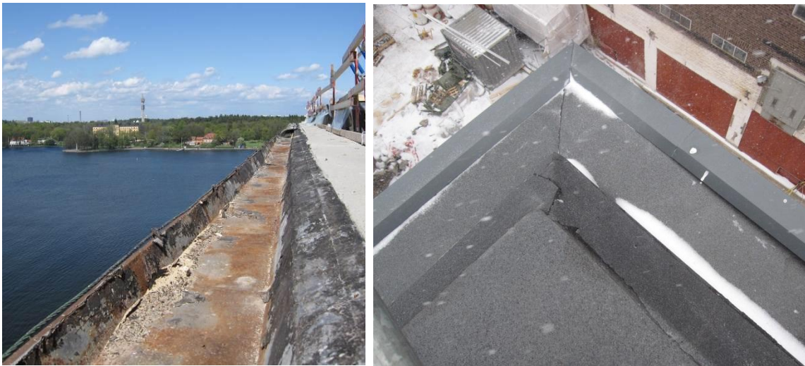
Gesimsrännan. T v: den frilagda rostiga plåten utmed västra fasaden. T h: Färdig detalj vid sydöstra hörnet.
