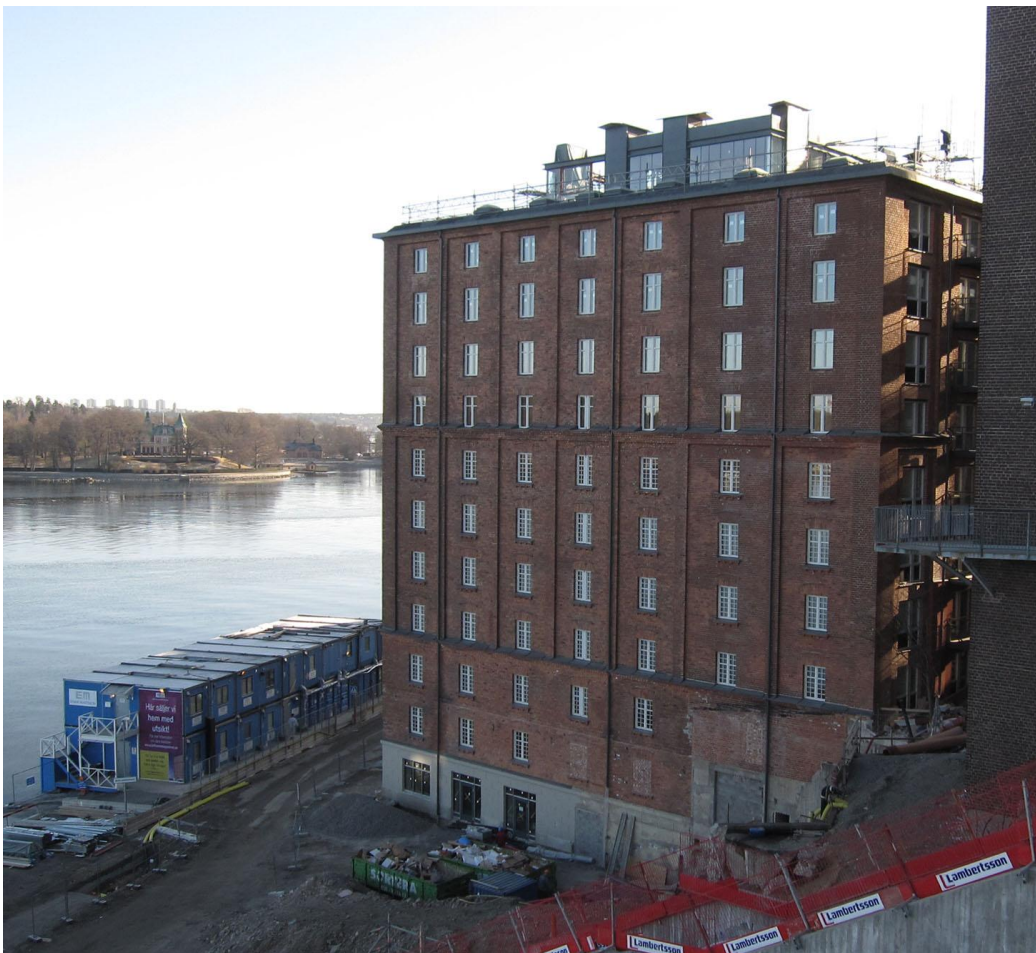
Fasader mot väst och (del av) mot söder samt den nya, indragna takpåbyggnaden.
