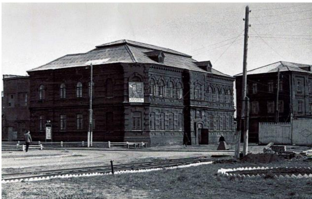
Рис.30. Архивная фотография середины XX века выявленного объекта культурного наследия «Жилой дом №6». К этому времени уже были утрачены балкон, щипцы над ризалитами, козырек над парадным входом, заложены кирпичом несколько окон.
