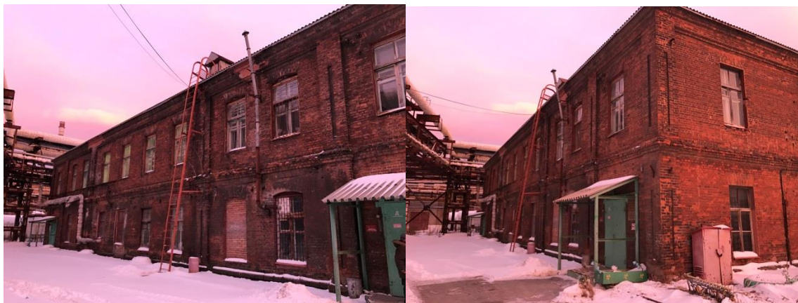
Рис. 13. «Жилой дом» (здание с кадастровым номером 59:03:02 00007: 2147). Северо-восточный и северо-западный торцевой фасады. Фото декабрь, 2017 г.
