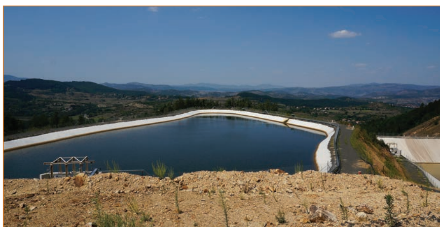
Резервоарът за технологични води, вдясно е по-малкият за дъждовни води
