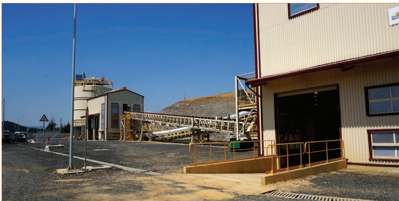
Обогатителната фабрика с поглед към трошачния цех и силоса за руда
