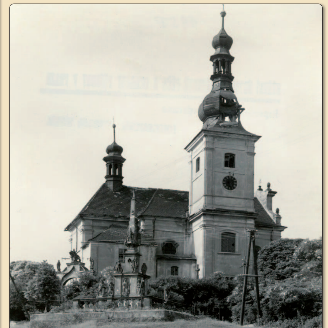
Sloup Čtrnácti svatých pomocníků před kostelem v Čachovicích.
