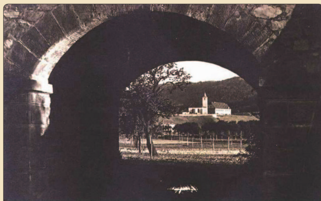
Pohled na kostel skrz klenbu viaduktu.
