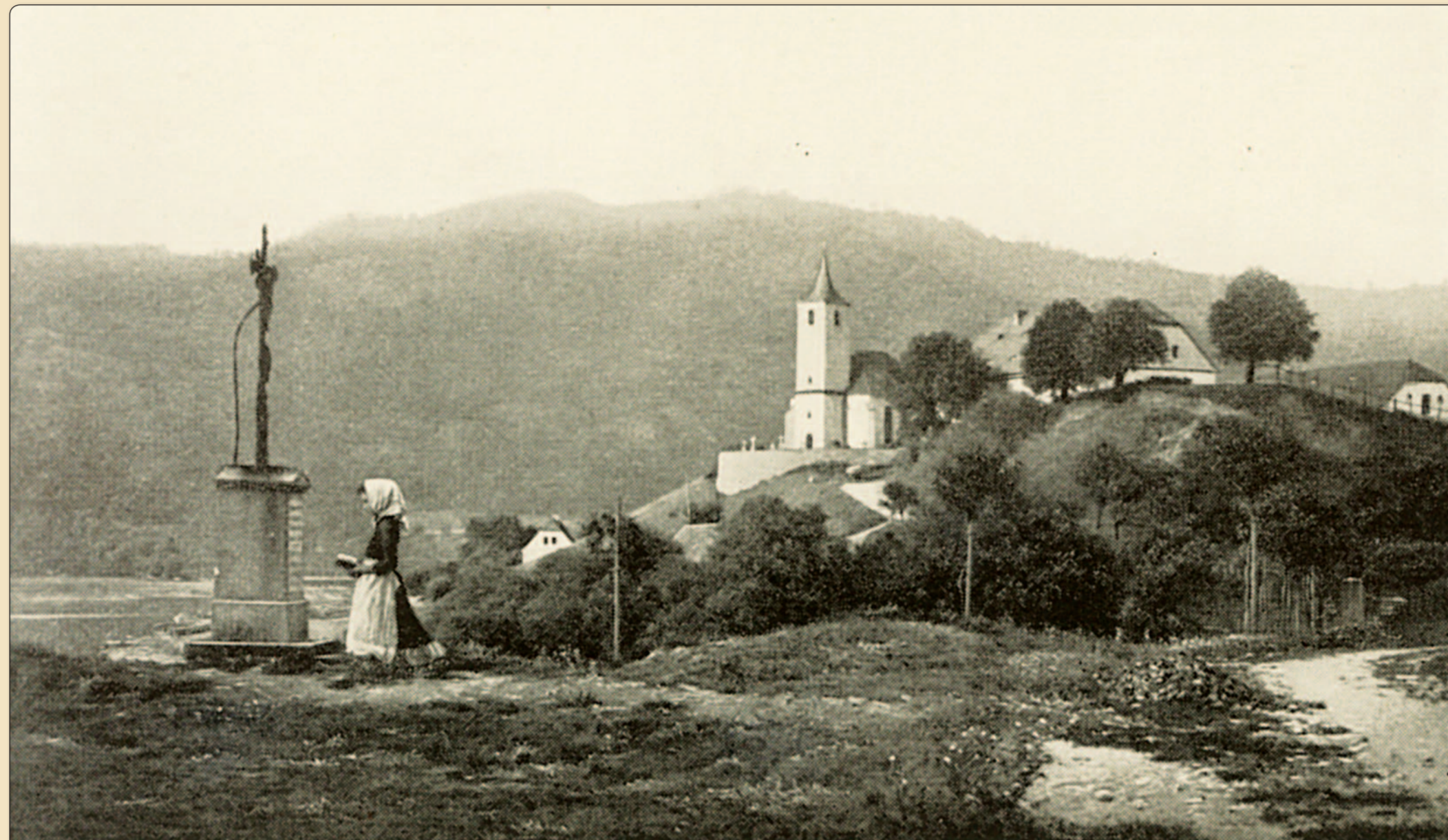
Fotografie místa, kde se nacházel ze železa ulitý pozlacený kříž na kamenném podstavci. V pozadí Kostel sv. Václava.
