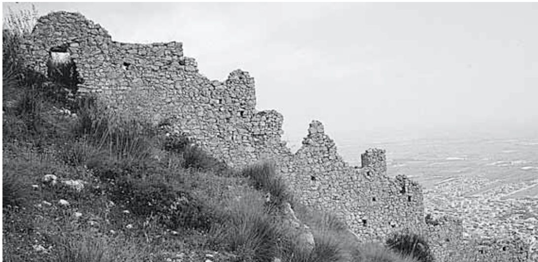
Fig. 5 – CA “D”: la cinta muraria occidentale.
