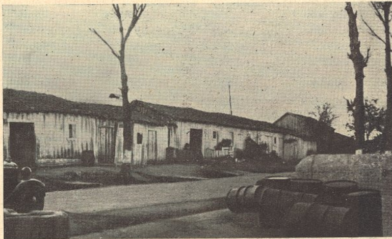
A saída da estação internacional da «Guarda». O seu estado é deplorável
