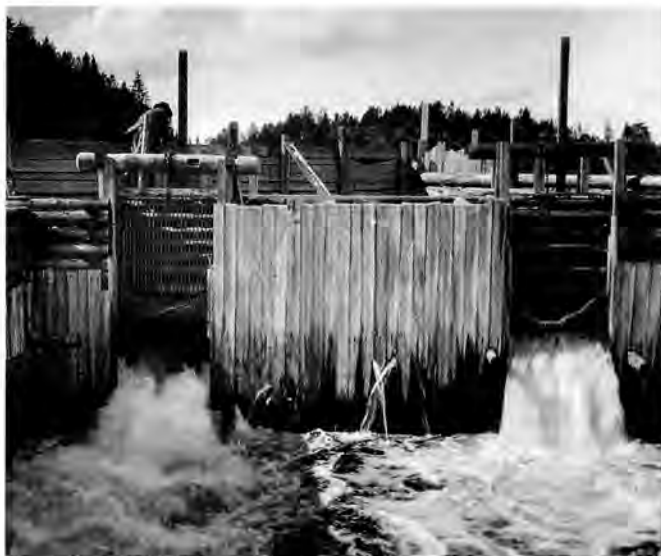
Klabböleanläggningen fotograferad uppströms. Foto omkring 1930.
