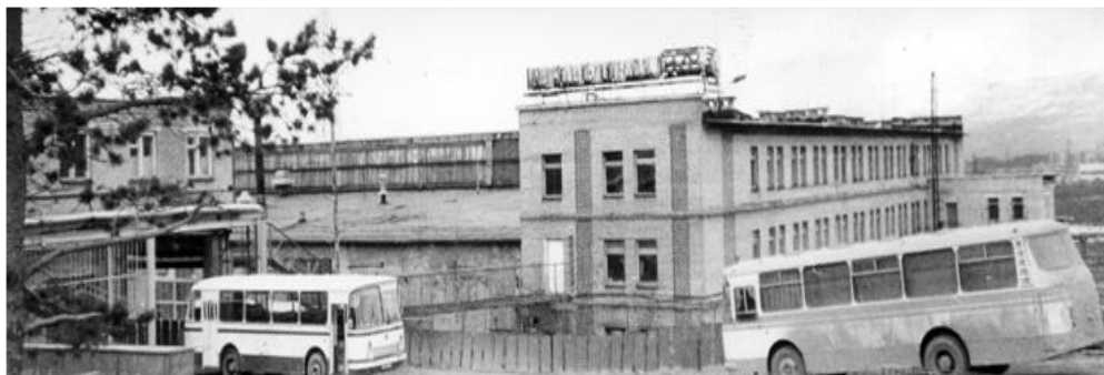
Здание управления автоколонны № 1378. 1989 г. ГОКУ ГАМО в г. Кировске. Ф. Р-19. Оп. 4. Д. 571.
