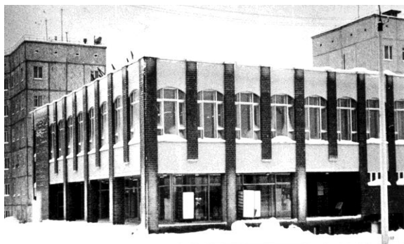
Новый универсам на улице Жемчужной. 1988 г. ГОКУ ГАМО в г. Кировске. Ф. Р-19. Оп. 4. Д. 415.
