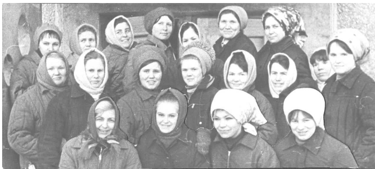
Лучшая бригада маляров СУ «Отделстрой» треста «Апатитстрой» Е.И. Ковалевой. 1971 г. ГОКУ ГАМО в г. Кировске. Ф. Р-520. Оп. 1. Д. 939.
