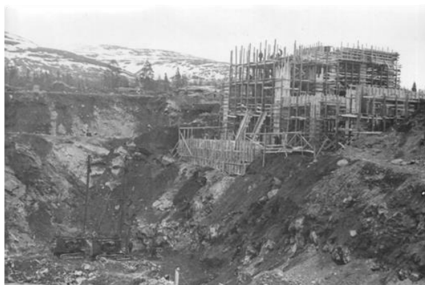
Подготовка котлована для корпуса крупного дробления АНОФ-2. Июнь 1958 г. ГОКУ ГАМО в г. Кировске. Ф. Р-520. Оп. 1. Д. 566.
