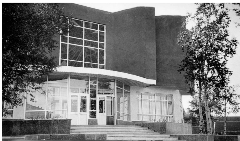
Новое здание библиотеки и музея трудовой славы треста «Апатитстрой». 1990 г. ГОКУ ГАМО в г. Кировске. Ф. Р-19. Оп. 4. Д. 665.
