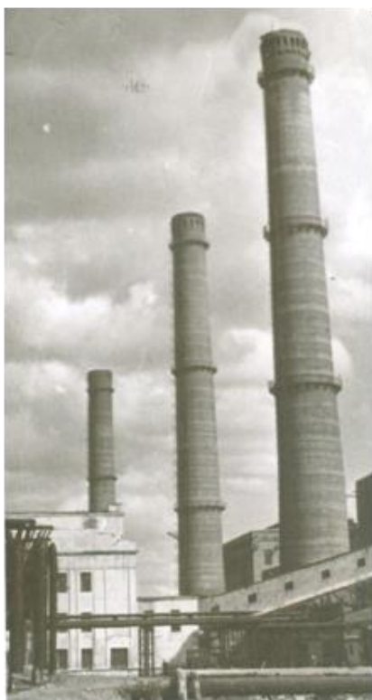
Кировская ГРЭС - могучий источник электроэнергии 1968г. ГОКУ ГАМО в г. Кировске. Ф. Р-19. Оп. 2. Д. 305.
