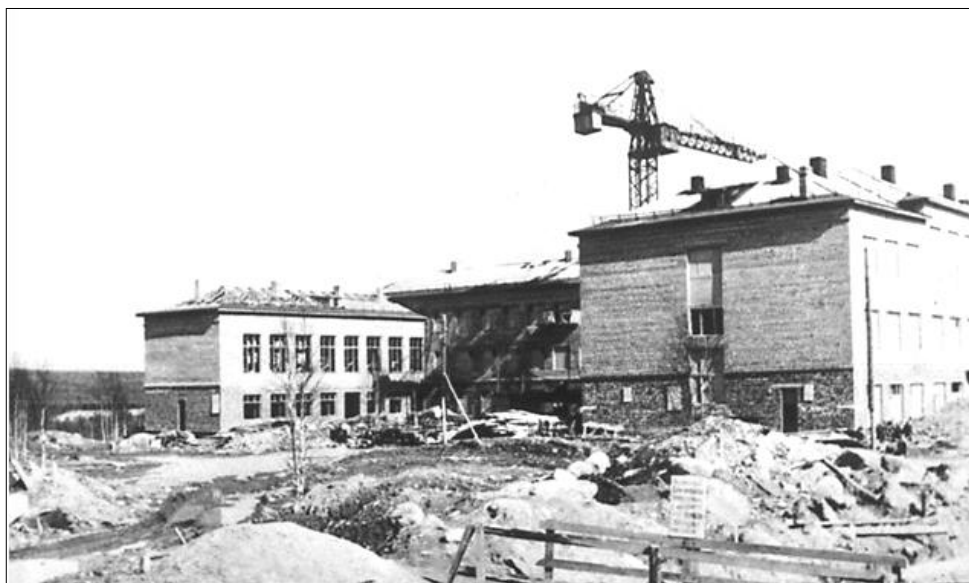
Идет строительство школы в Новом городе. 1962 г. ГОКУ ГАМО в г. Кировске. Ф. Р-42. Оп. 6. Д. 445.
