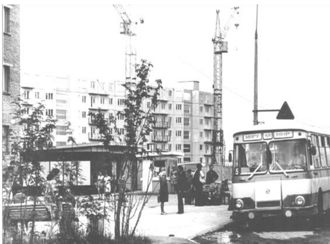
Строительство 9-ти этажного дома на площади Геологов. 1975 г. ГОКУ ГАМО в г. Кировске. Ф. Р-520. Оп. 1. Д. 1967.
