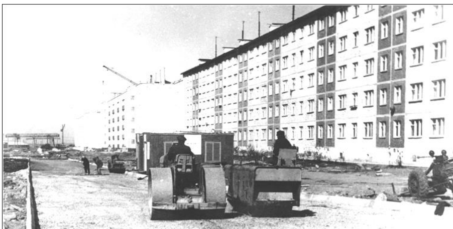
СМУ «Спецстрой» треста «Апатитстрой» ведет строительство дороги. 1979 г. ГОКУ ГАМО в г. Кировске. Ф. Р-520. Оп. 1. Д. 2899.
