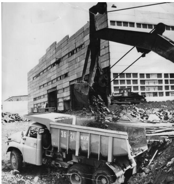
СМУ «Рудстрой» ведет строительство автобазы для рудника Центральный. 1976 г. ГОКУ ГАМО в г. Кировске. Ф. Р-520. Оп. 1. Д. 2460.
