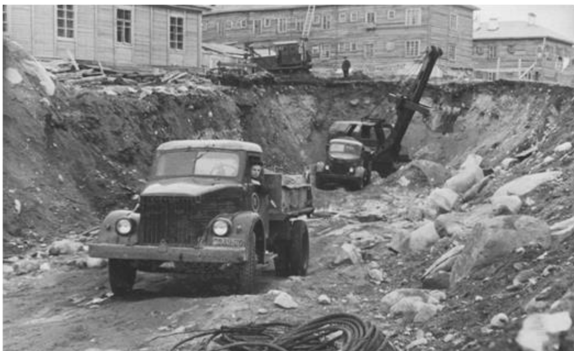
Рытье котлована для нового строительного объекта. 1951 г. ГОКУ ГАМО в г. Кировске. Ф. Р-179. Оп. 12. Д. 247.
