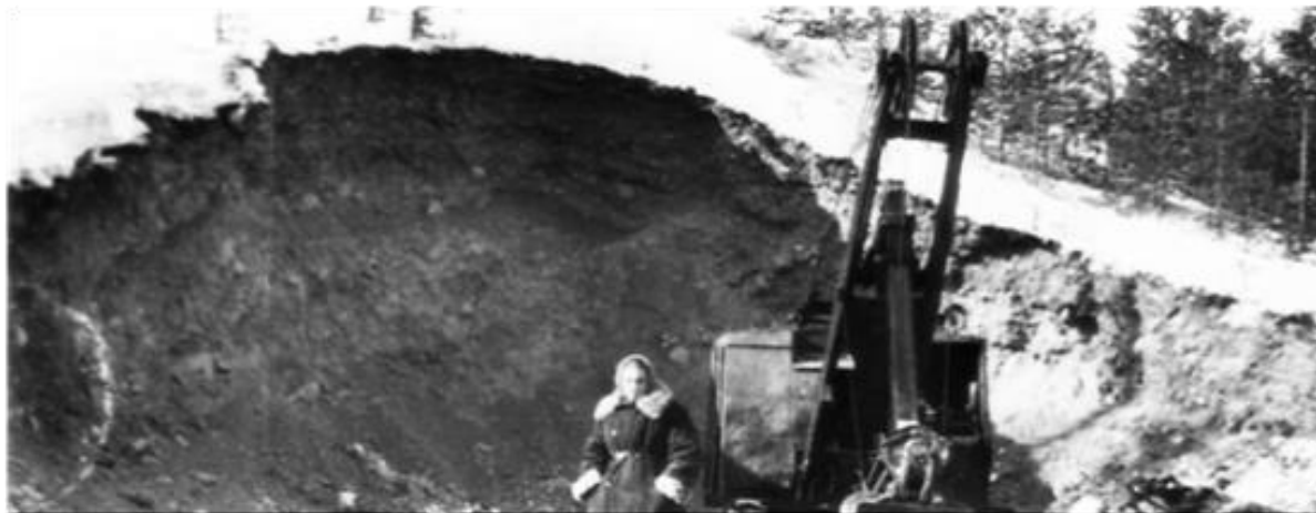
Начало строительства водовода Имандра-ГРЭС. 1957 г. ГОКУ ГАМО в г. Кировске. Ф. Р-42. Оп. 6. Д. 209.
