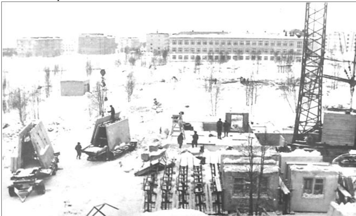
Крупнопанельное домостроение. Новый город. 1963 г. ГОКУ ГАМО в г. Кировске. Ф. Р-42. Оп. 6. Д. 489.
