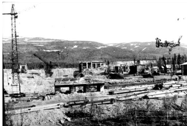
Панорама строительства АНОФ-2. 1962 г. ГОКУ ГАМО в г. Кировске. Ф. Р-42. Оп. 6. Д. 457.
