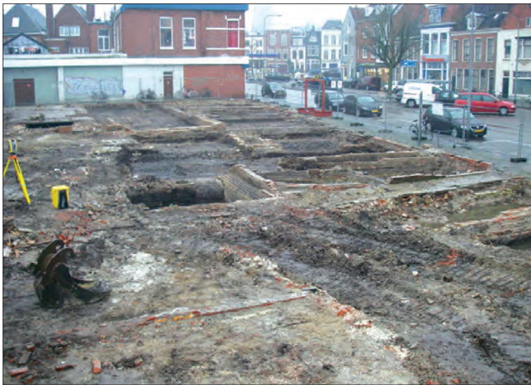
Afb. 6. Funderingen en muurwerk aan het Boterdiep. Foto: Anko Wieringa, collectie Dienst RO/EZ.
