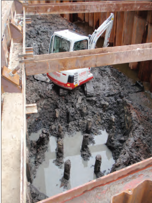
Afb. 2. Abrug: Funderingspalen van de 12e-eeuwse Abrug. Foto: Gert Kortekaas, collectie Dienst RO/EZ.
