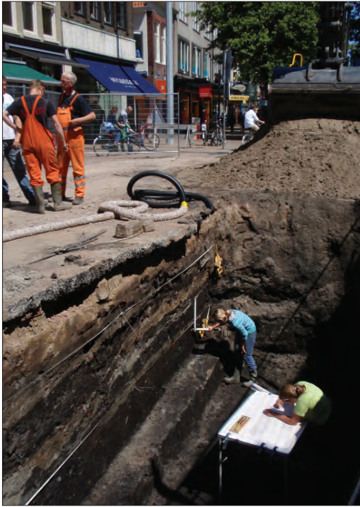
Afb. 3. Proefsleuf in de Brugstraat (zuidzijde ter hoogte van nr. 8) waarop boven de humeuze vulling van de berm-sloot zandlagen van wegdekken uit de late middeleeuwen. Foto: Gert Kortekaas, collectie Dienst RO/EZ.
