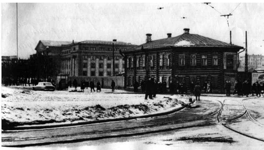
Перекресток пр. Ленина с ул. Луначарского.
