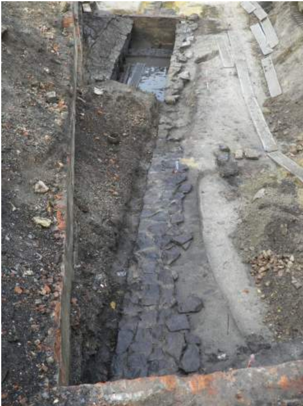
Figuur 3.3.9.1-2: Houten constructie 1087 en versteningsfase, achteraan het blootgelegde gedeelte van de originele houten constructie
