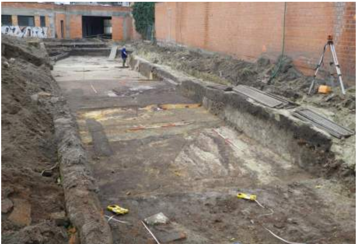
Figuur 3.3.3.3-6: Werkput 3 niveau 2, brede uitgraving en greppel, gezien vanuit het noorden
