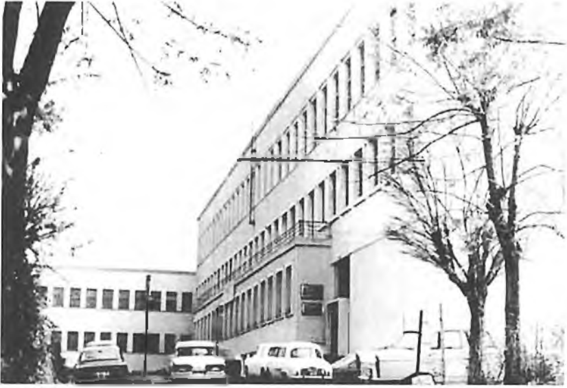
1960'da Fakültenin sağ alt köşesi yapılmış ancak ön merdiven yapılmamış.
