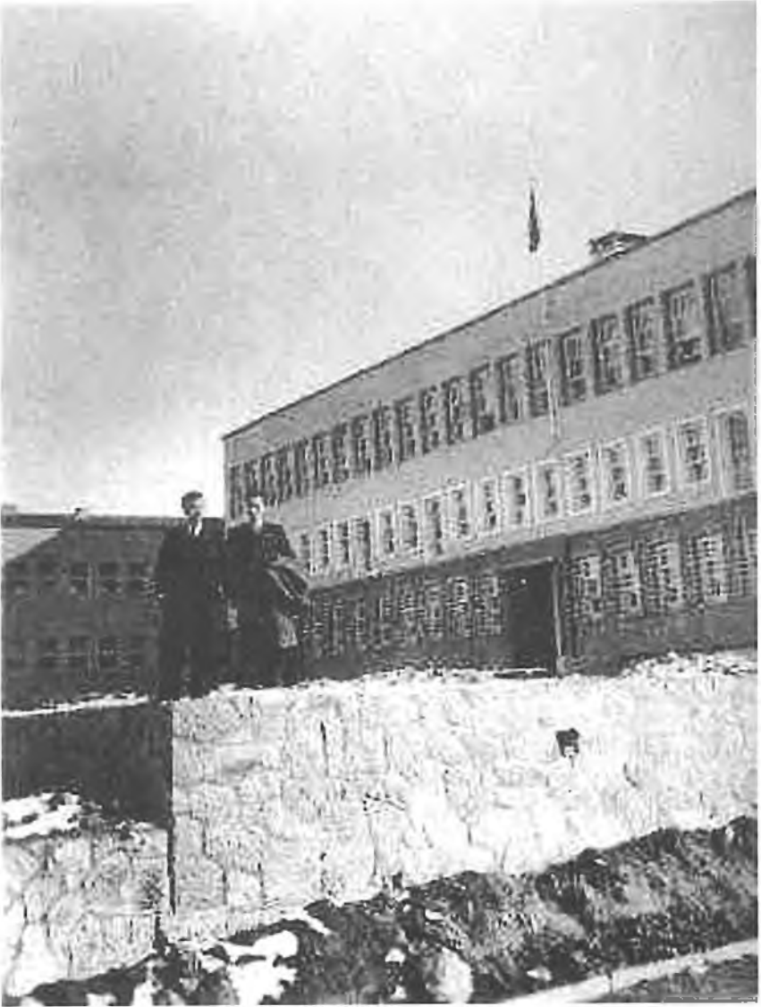
1937 yılı, SBO'nun ön bahçesinde duvar inşaatının yapılışı.
