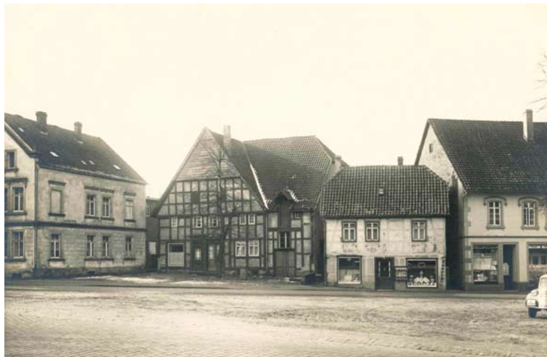
Begastraße 1-7 vor dem Abriss des Hauses Korte (Begastraße 3), Februar 1938.
