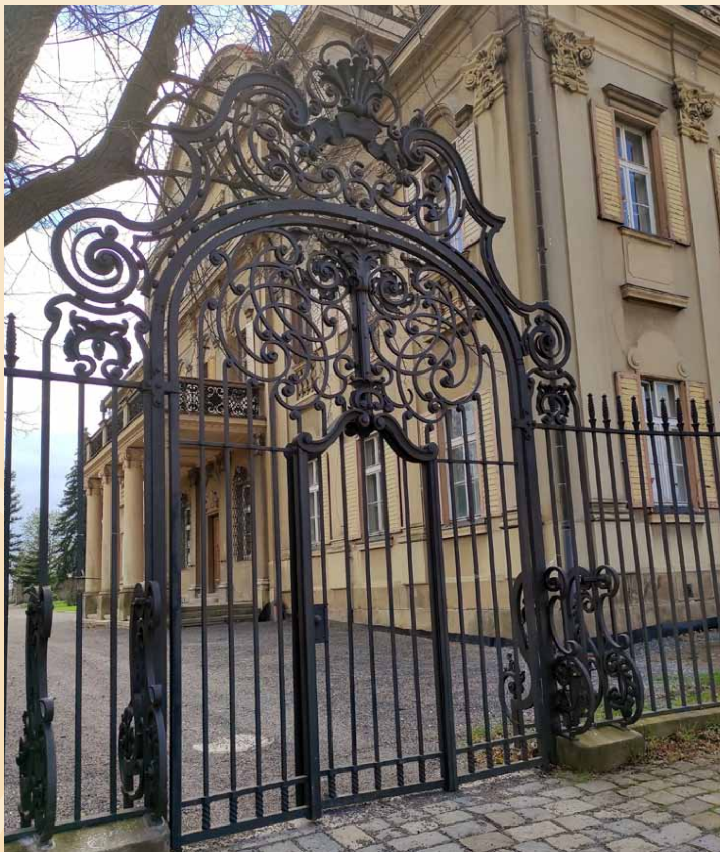
Vstupní brána po rekonstrukci
