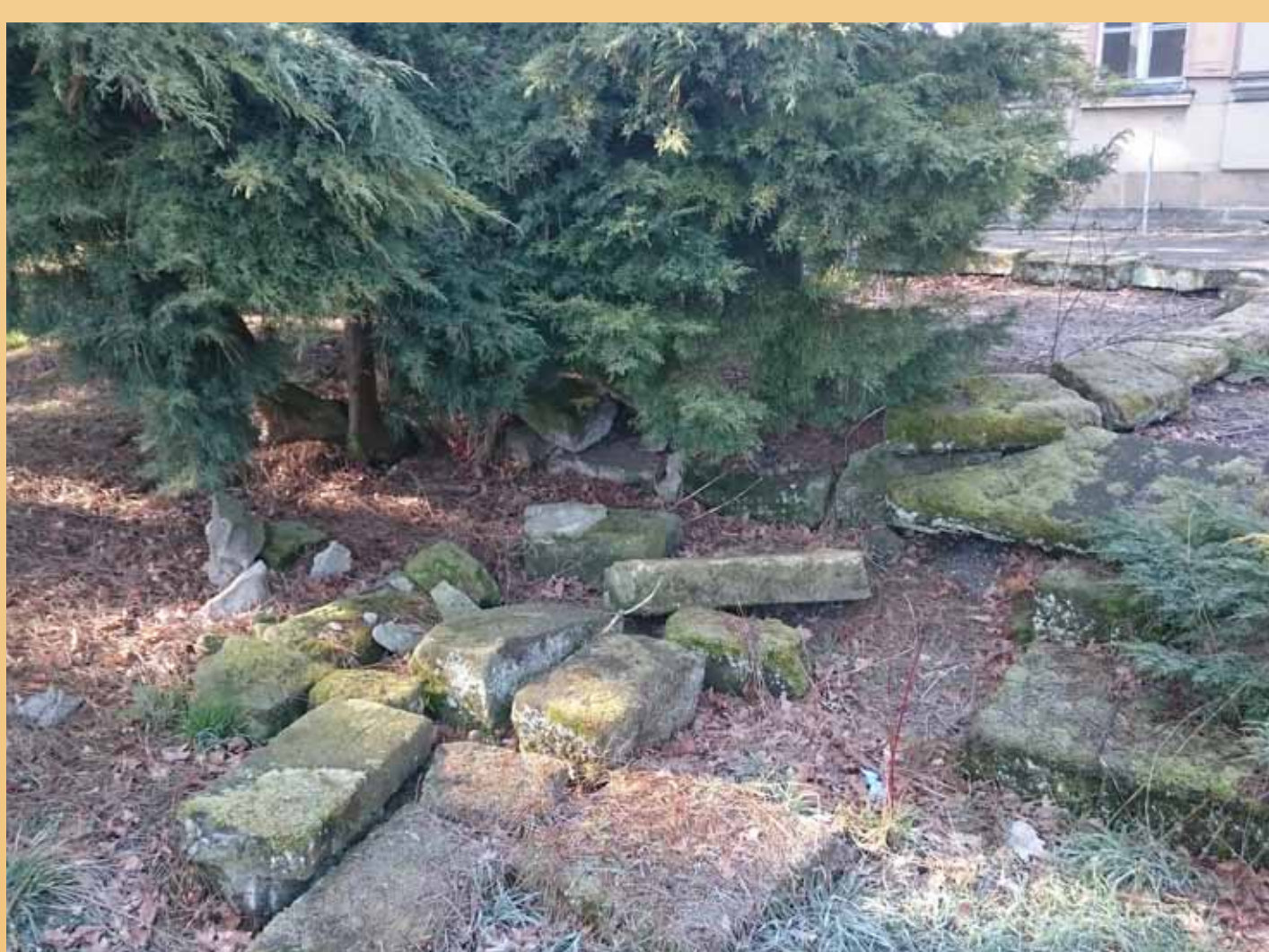
Pozůstatky balustrády před rekonstrukcí
