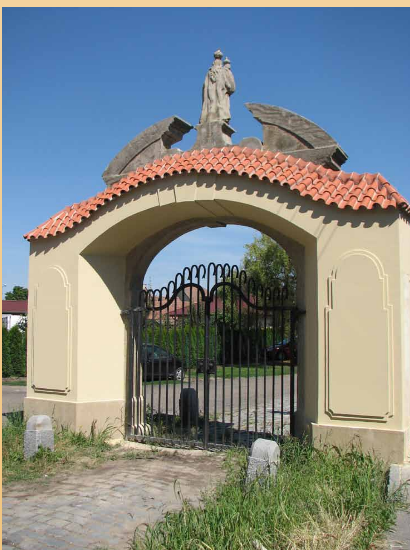
Brána po provedené rekonstrukci
