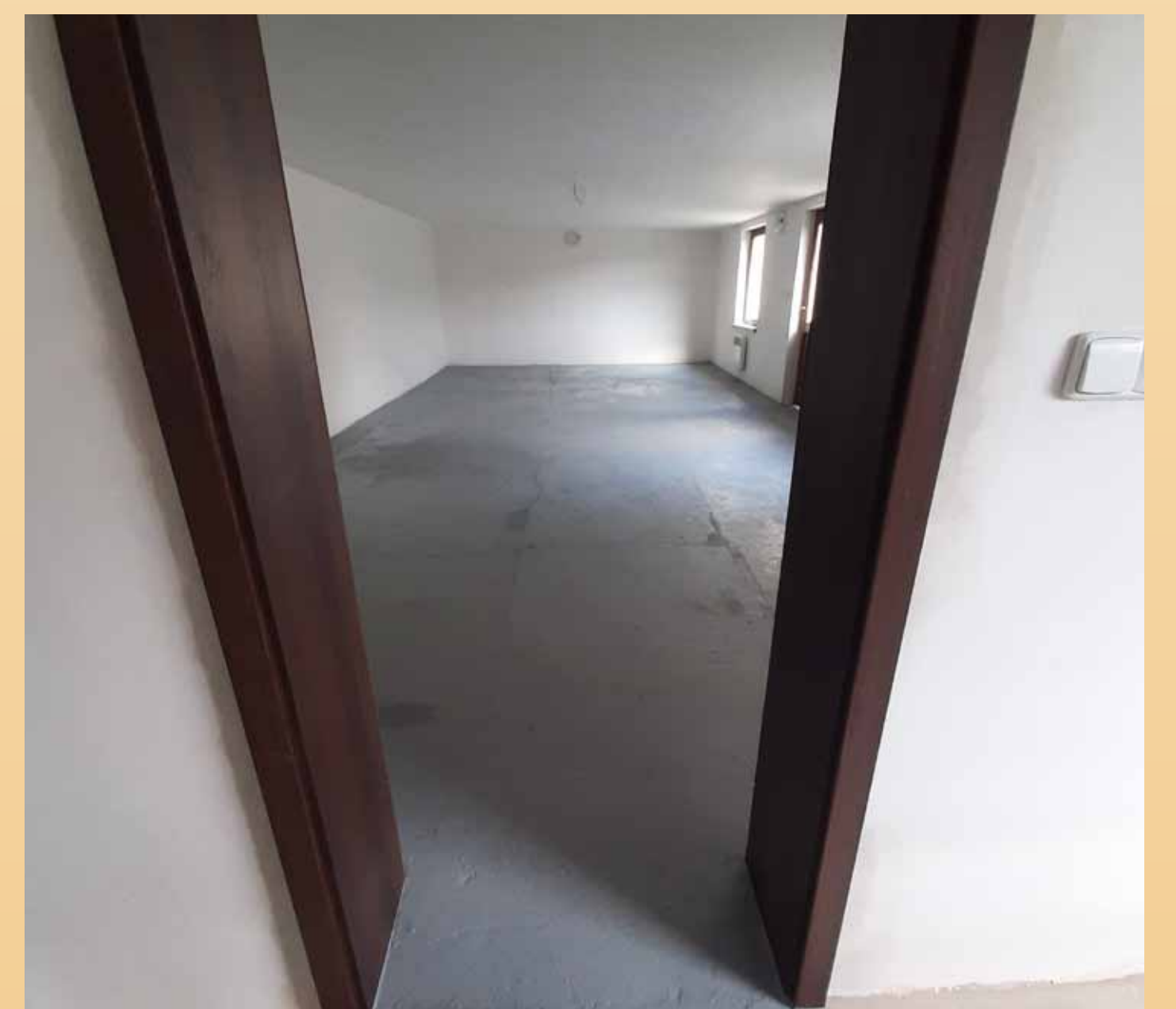
Vnitřní prostory v roce 2019
