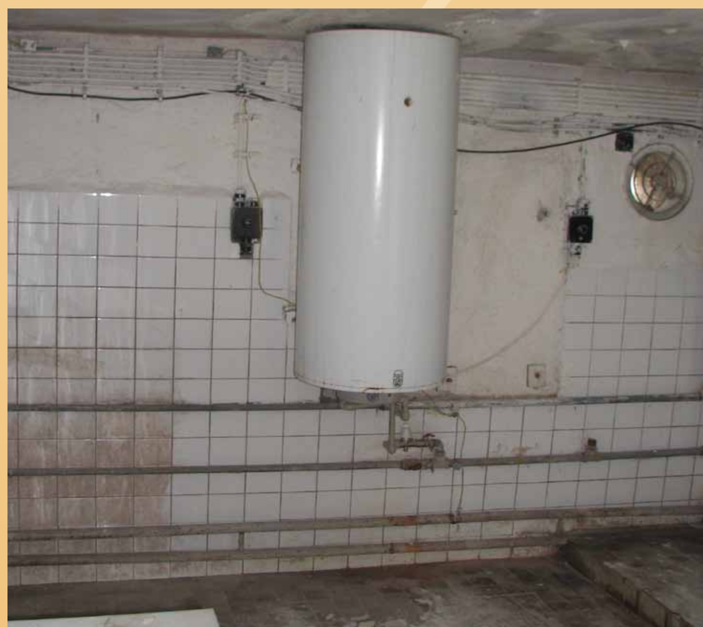
Vnitřek hospodářských budov v roce 2015
