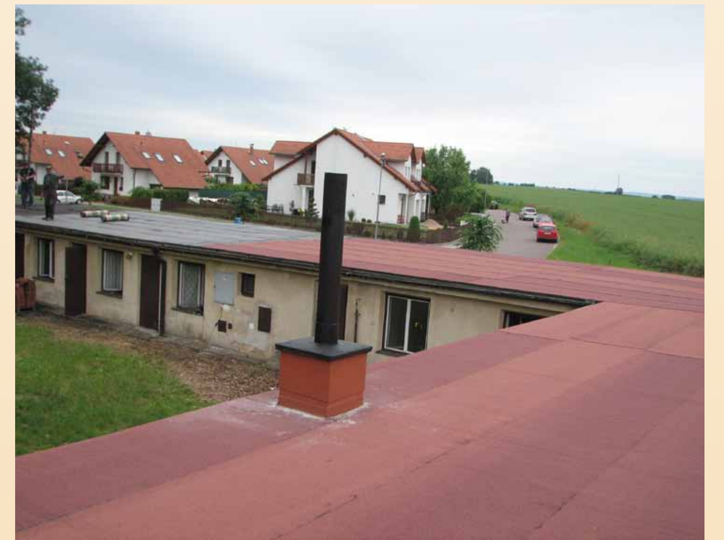
Oprava střechy na hospodářských budovách v roce 2015
