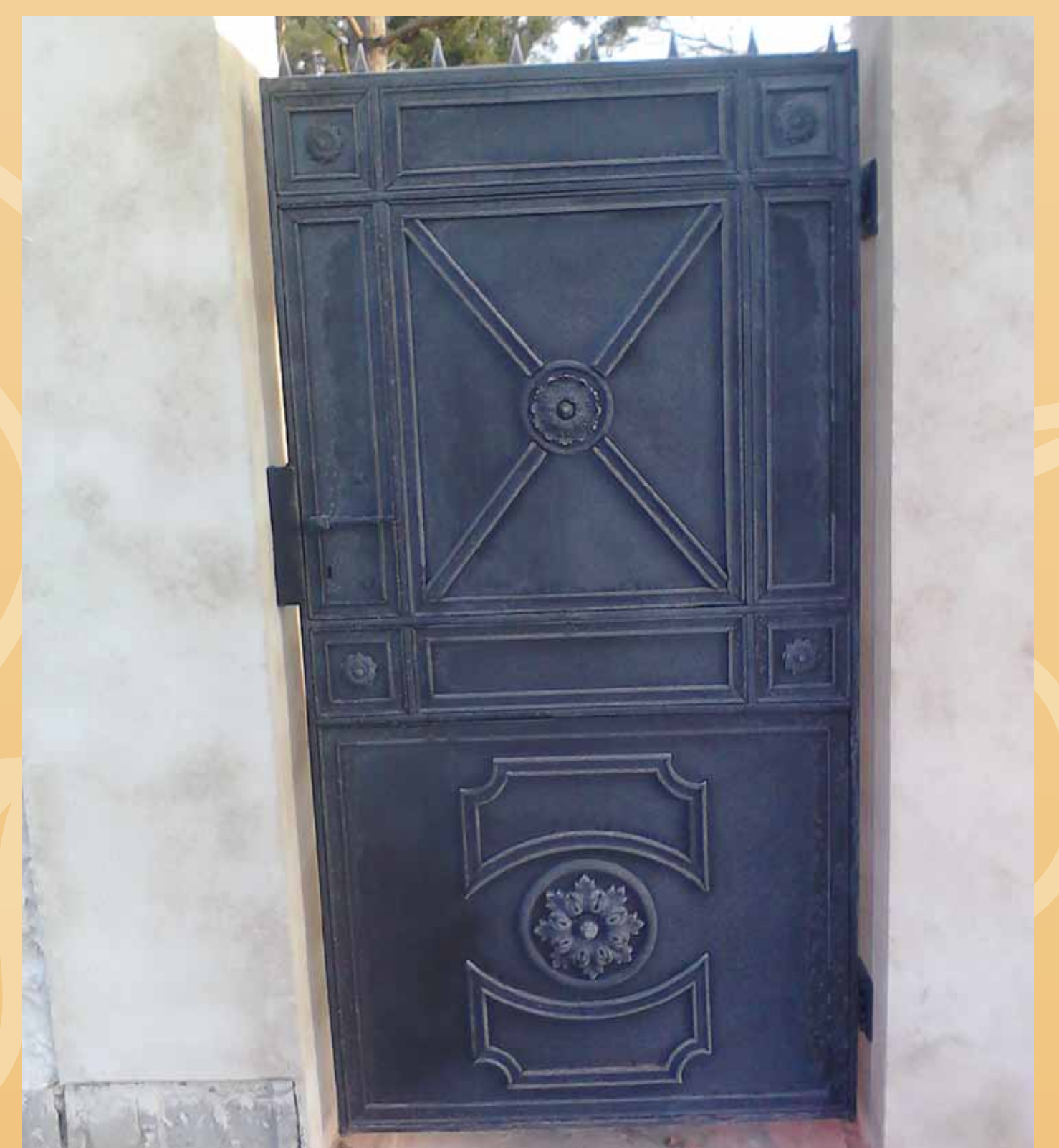
Reinstalace obnovené kovové branky v roce 2013
