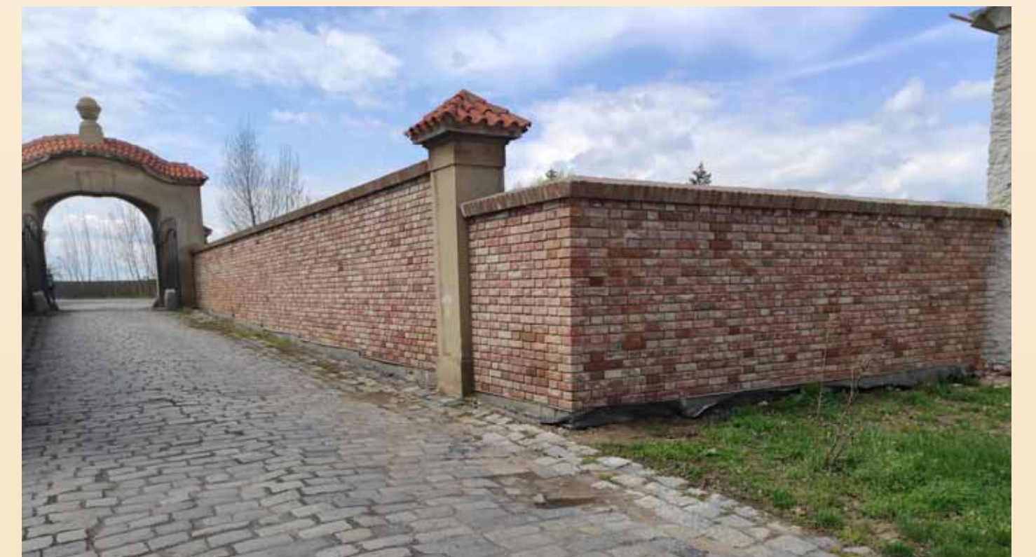
Oplocení po rekonstrukci v roce 2018
