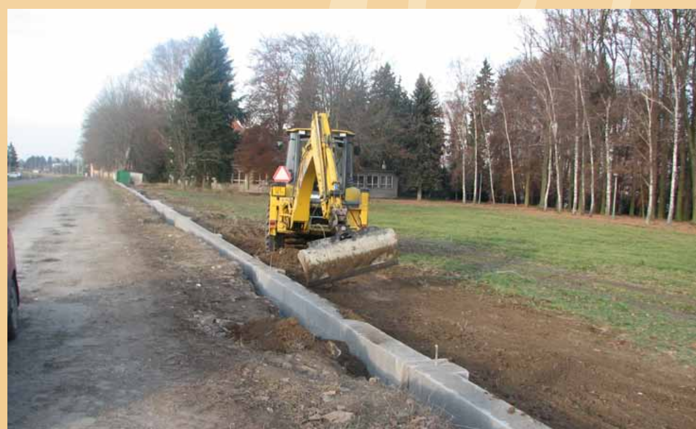
Stavba základů západního oplocení v roce 2011
