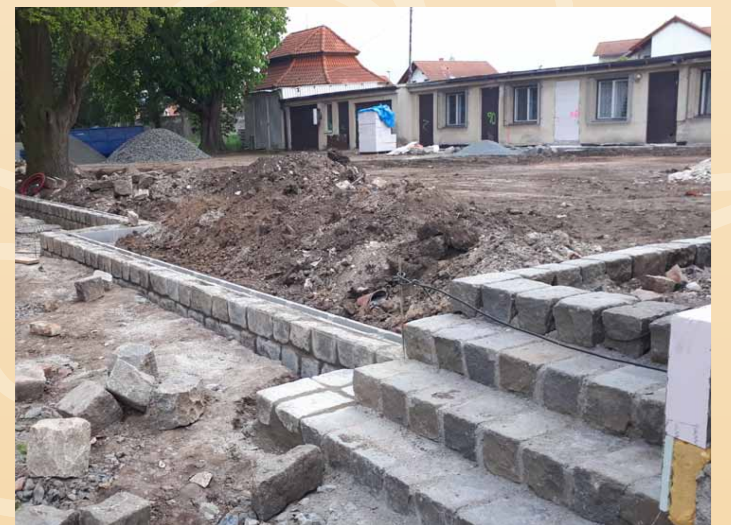
Venkovní terénní úpravy v roce 2019
