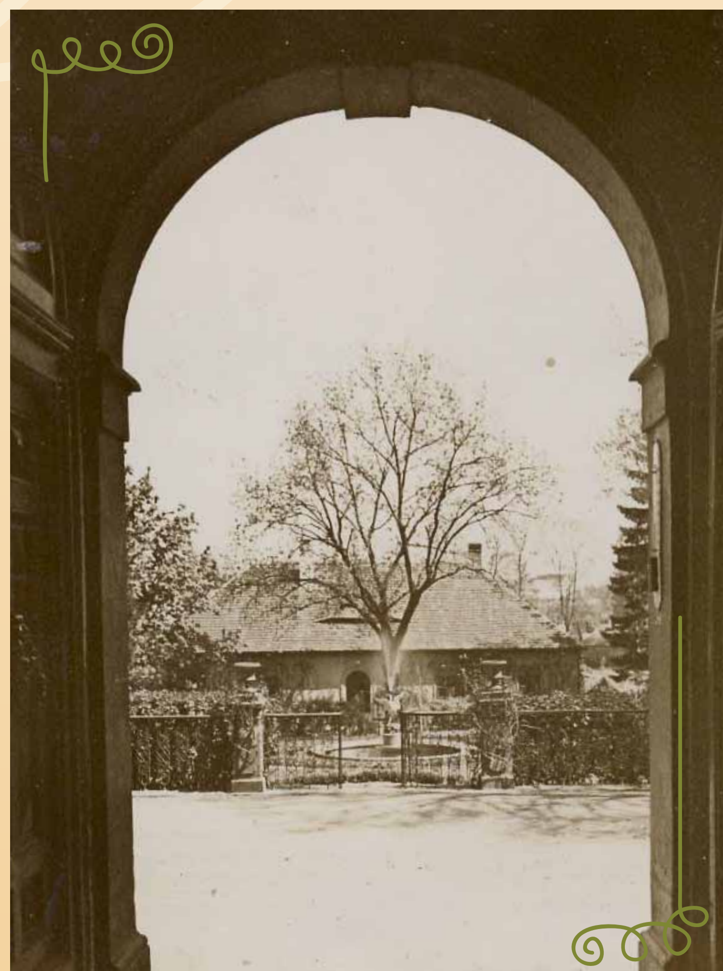
Průhled do pravidelné části, tzv. parteru, který byl na začátku 20. století ohrazen kovovým plotem
