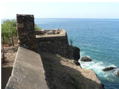
Photo 57 Ruines du Fort São Veríssimo
