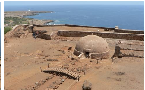
Photo 54 La réserve d'eau protégée par une coupole
