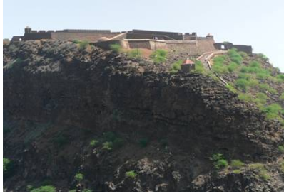
Photo 46 La forteresse a été construite sur la pointe de la falaise
