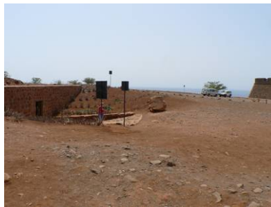
Photo 167 Le centre d'accueil enterré qui sert aussi de magasin de souvenir
