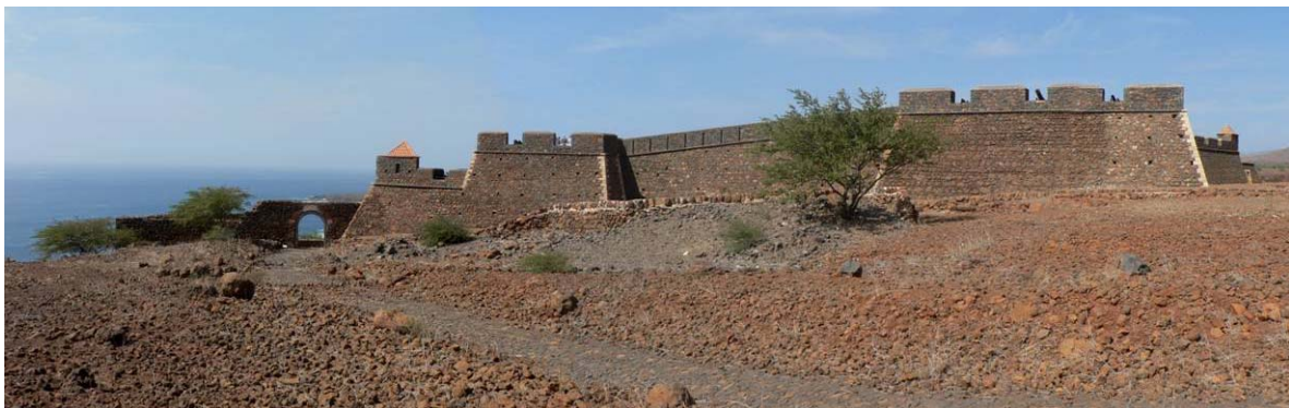
Photo 44 La façade Est de la forteresse São Felipe. La porte sur la gauche est l'accès initial qui reliait le Fort à la ville.
