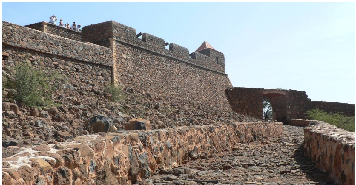
Photo 45 La façade Est de la forteresse São Felipe
