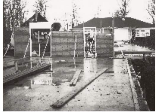
De bouw van de zuidvleugel
