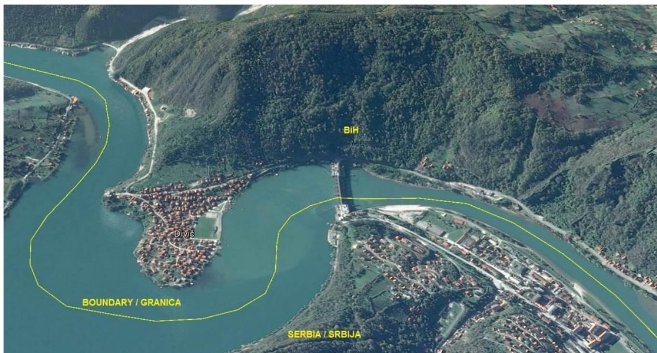
Slika 8-5: Lokacija brane i akumulacije „Zvornik“
