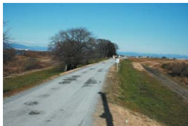
長良川締切堤の木曾川側 (成戸・小藪間締切堤部分) 下流側より
