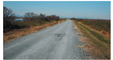
木曾長良背割堤(塩田・日原間締切堤部分)下流側より
