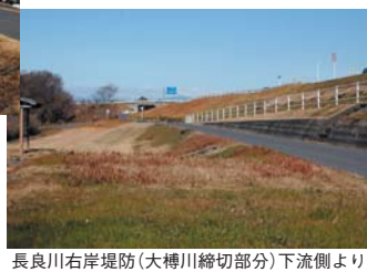
長良川右岸堤防(大樽川締切部分)下流側より
