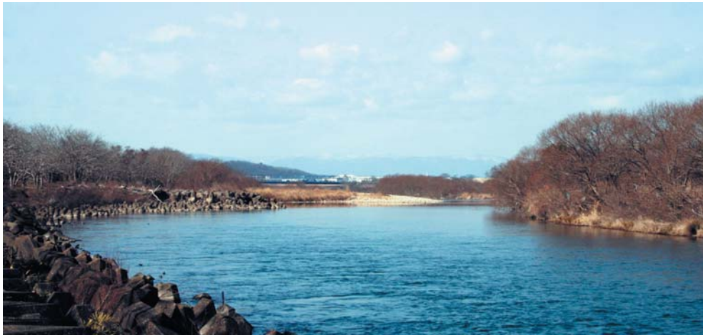
木曾川山那付近の風景(上流より)
