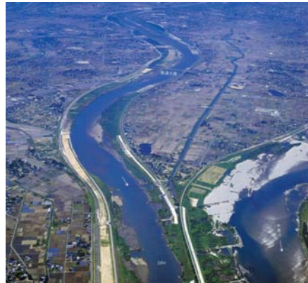
小藪の長良川締切堤(成戸・小藪間締切堤部分)下流側より
