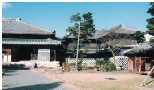
デ・レーケが泊まった早川家(平田町三郷)、右側の建屋に洋間あり
