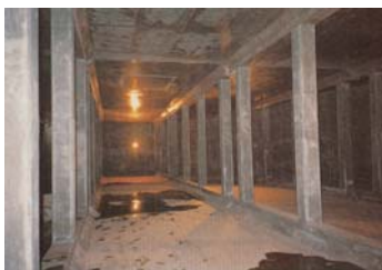
雨水貯留施設
