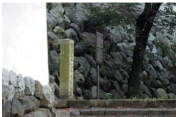
大垣城の石垣に刻まれた明治29年洪水氾濫水位
