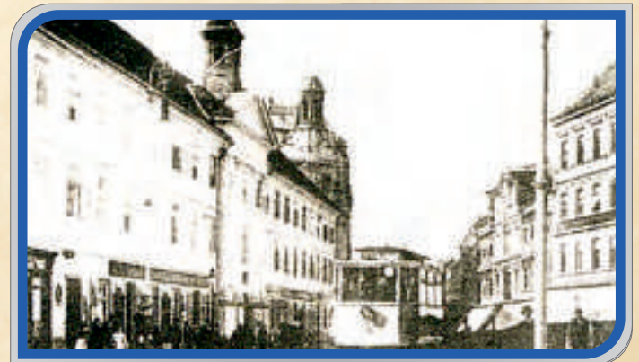
Pogled na Bolnicu sa sjeveroistoka
