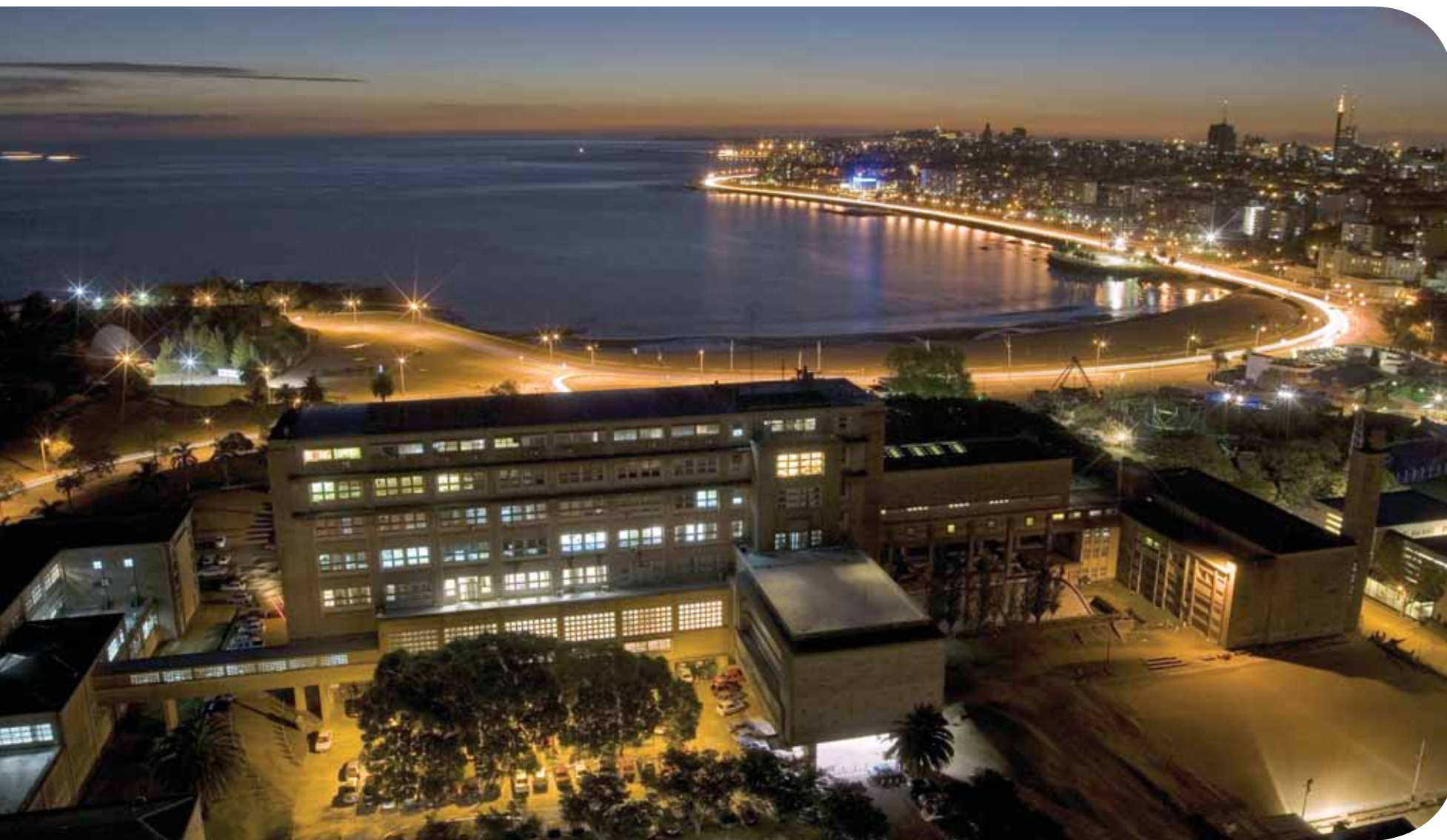
• Vista nocturna de la rambla montevideana con el edificio de la Facultad de Ingeniería en primer plano (Foto: Carlos Contrera / CMDF)
