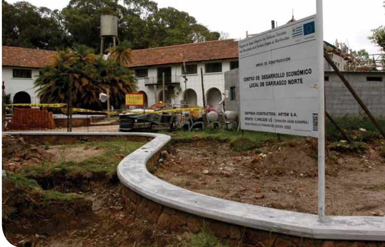
• Obras de infraestructura para la implementación del Centro de Desarrollo Económico Local de Carrasco Norte, Montevideo, Comisión Europea, PAPPUM.
