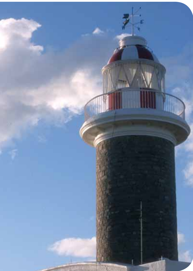
• Faro de Punta Carretas, Montevideo (Foto: CMDF)
