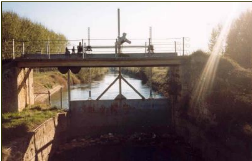
Figura 13. Presa de Calahorra (Palencia).
