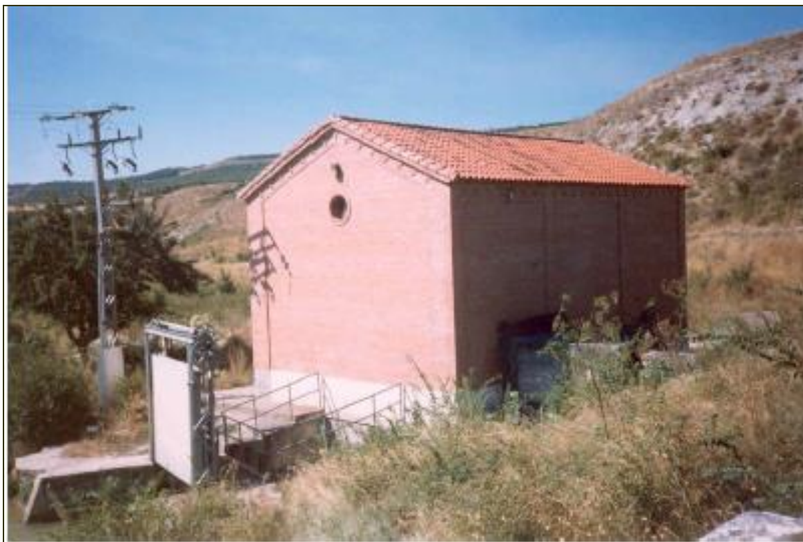
Figura 22. Central hidroeléctrica en las esclusas 34-35-36.
