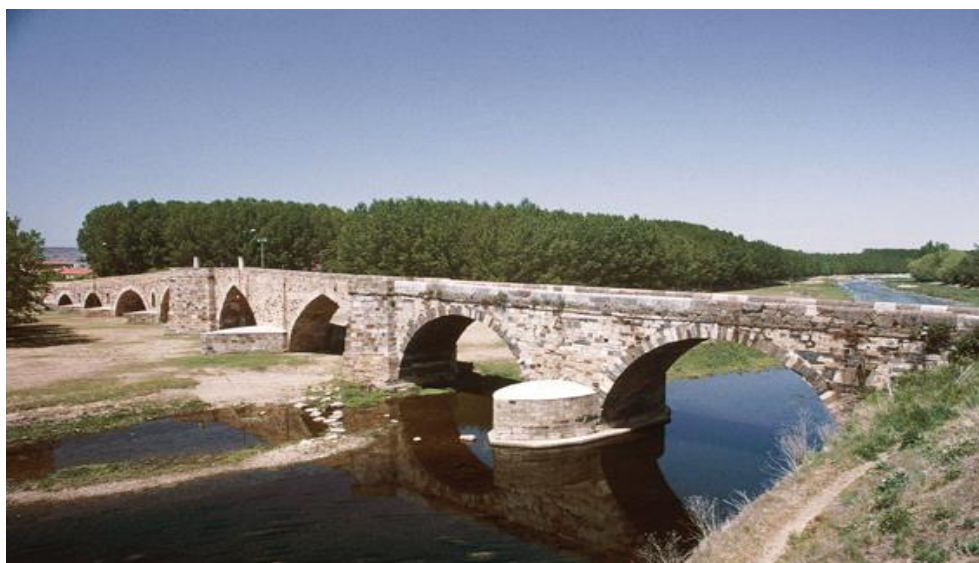
Figura 26. Puente de Hospital de Órbigo (León)
