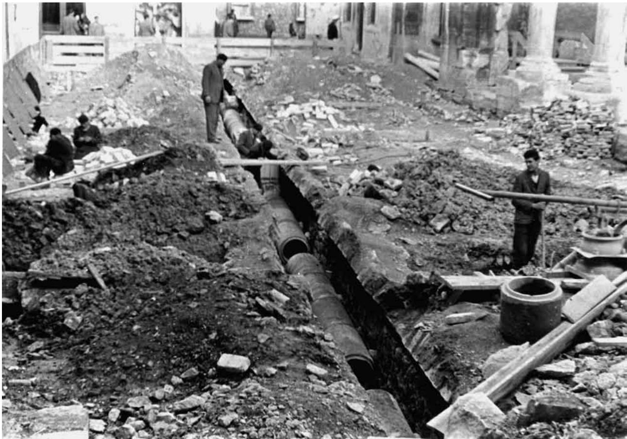
Sl. 104. Početak radova rekonstrukcije Peristila. Postava nove kanalizacijske cijevi
