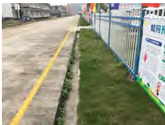
施工场地截排水沟
