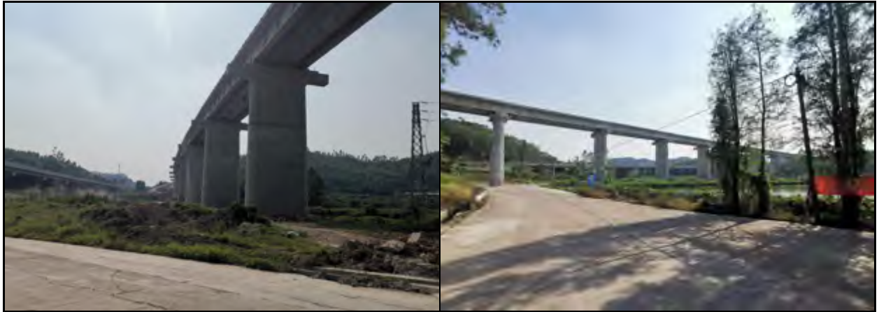
图 4.1-2 本工程邻近良溪村处施工现场照片
