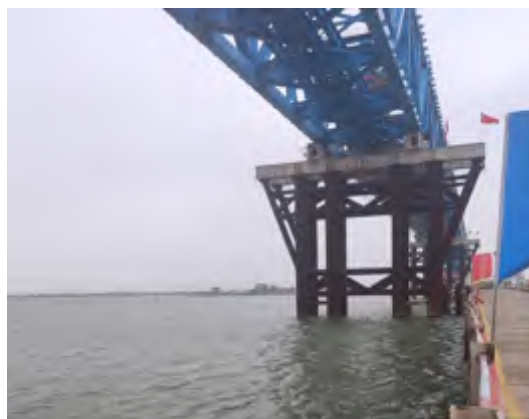
跨洪奇沥水道
