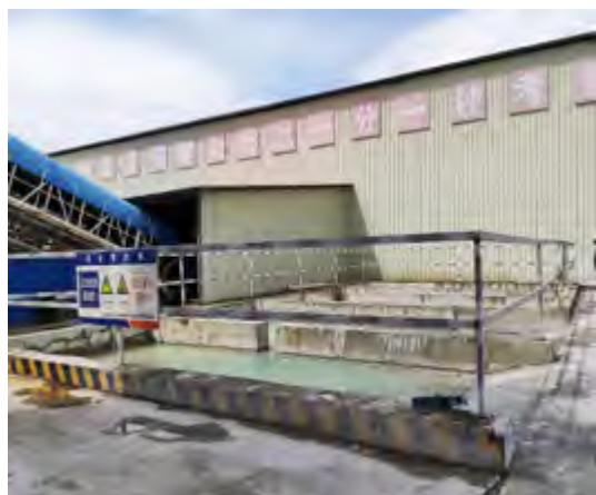
蓬江梁场沉淀池
