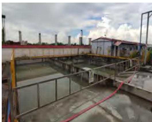
6 标 2#拌合站沉淀池
