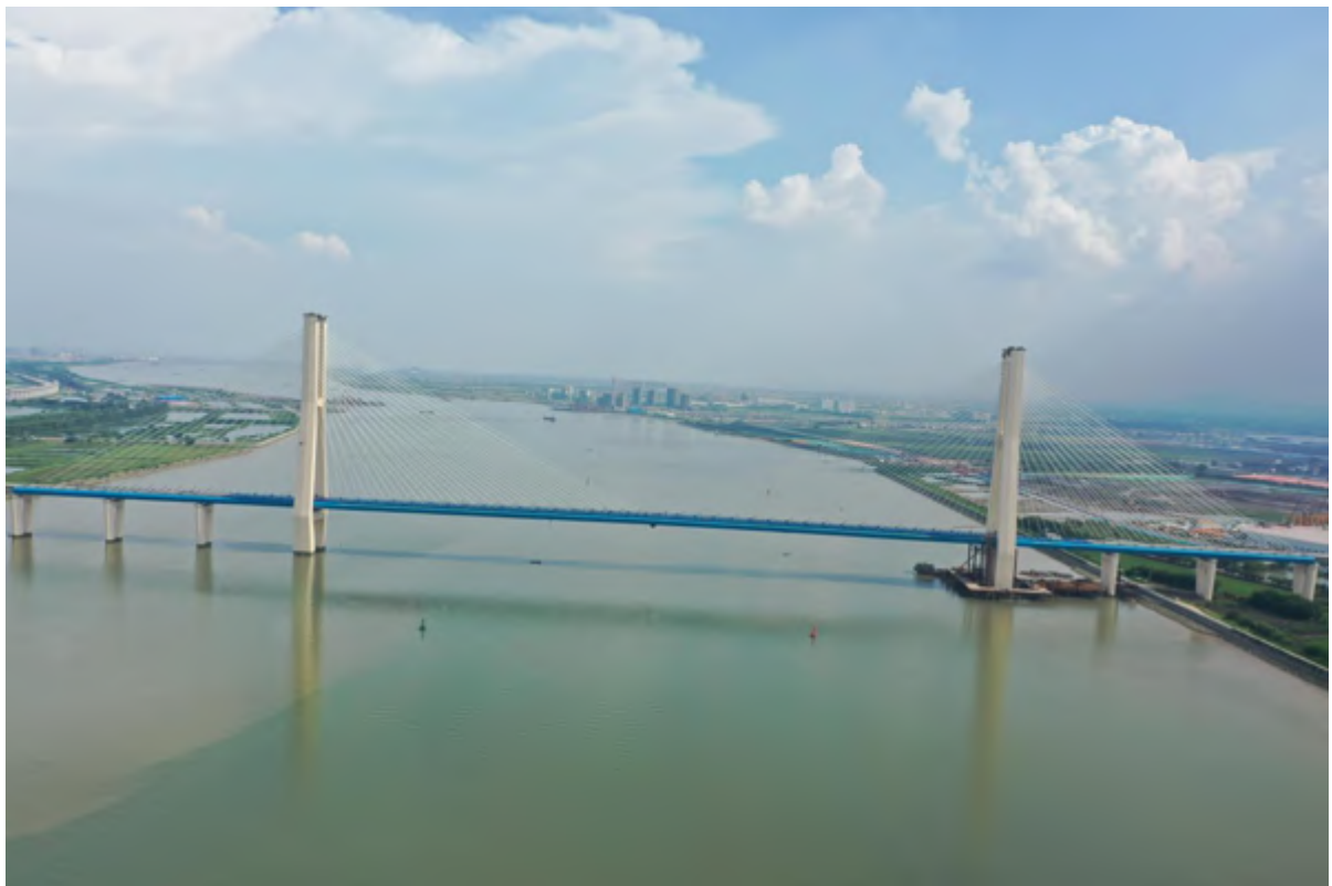
图 2.1-26 龙穴南水道特大桥现状（2021 年 4 月）
