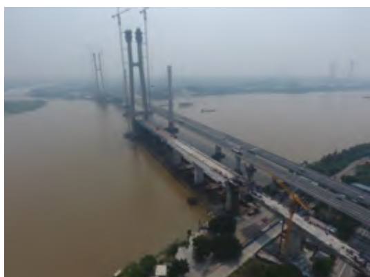
桥梁水中墩钢围堰
