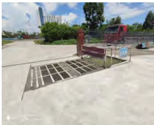
1 标 1#拌合站洗车池
