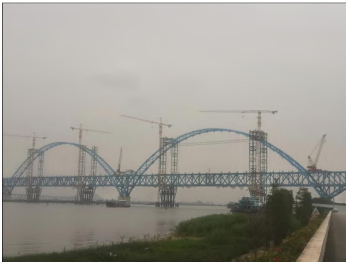
图 2.1-30 洪奇沥水道特大桥现状照片（2021 年 4 月）
