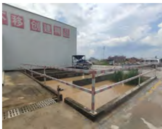
中山梁场沉淀池
