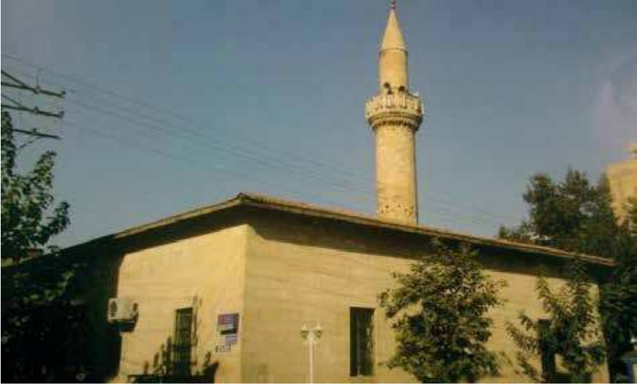
Eskisaray Camii Güneydoğu cephesinden görünüşü
