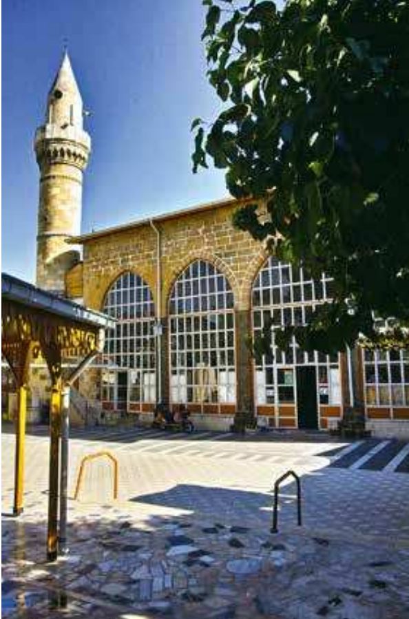
Şeyh Fethullah Camii
