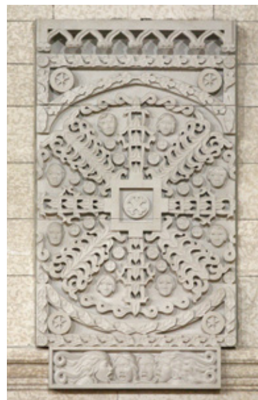
© Collection de la Chambre des communes, Ottawa
