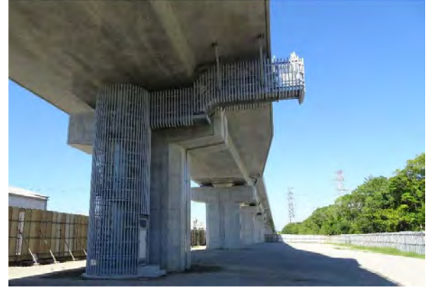
避難階段の設置
