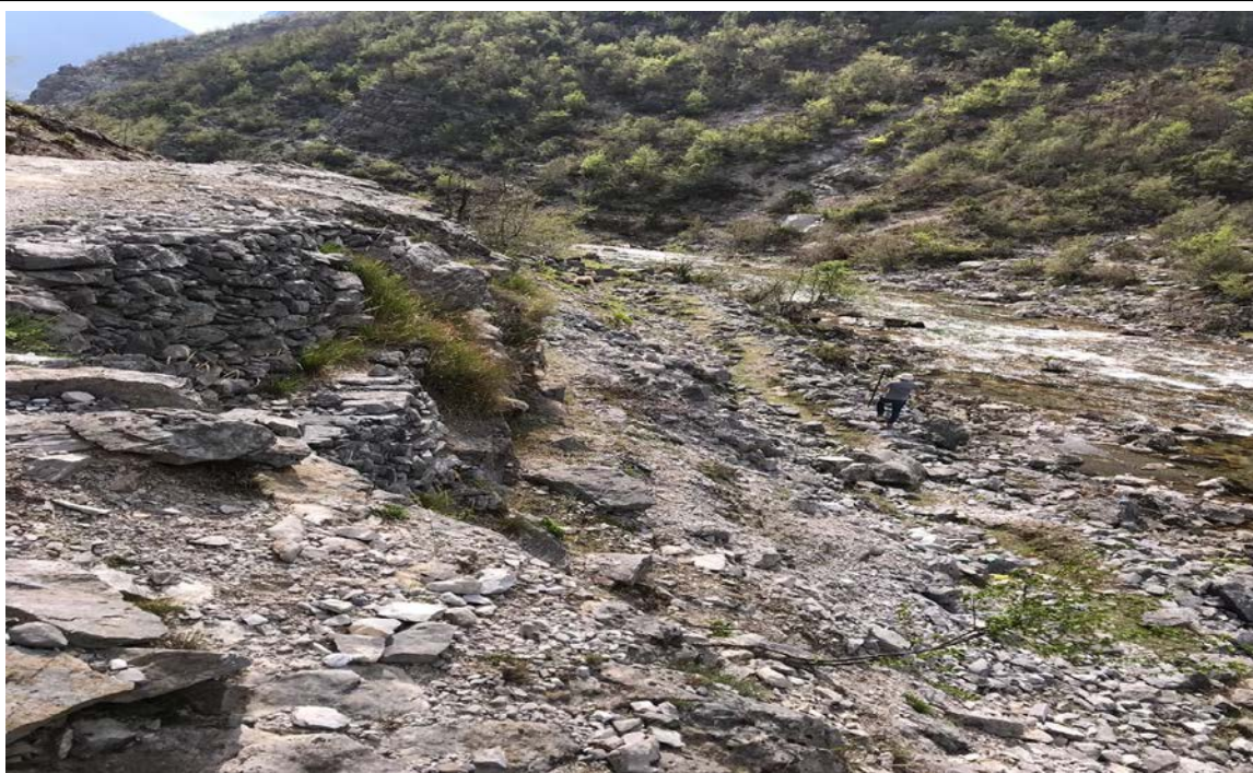
Figura 6. Bimesia e zones ku kalon tubacioni i derivacionit Hec Kozhnje 1
