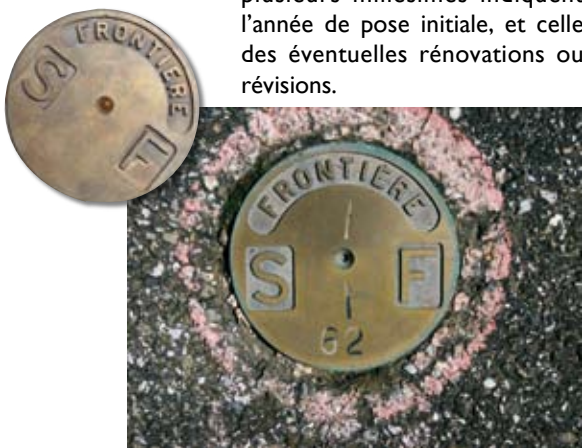
La cheville en laiton remplace la borne là où cette dernière gênerait la circulation : sur la chaussée, par exemple. Cliché © J. P. Wisard – État de Genève.
