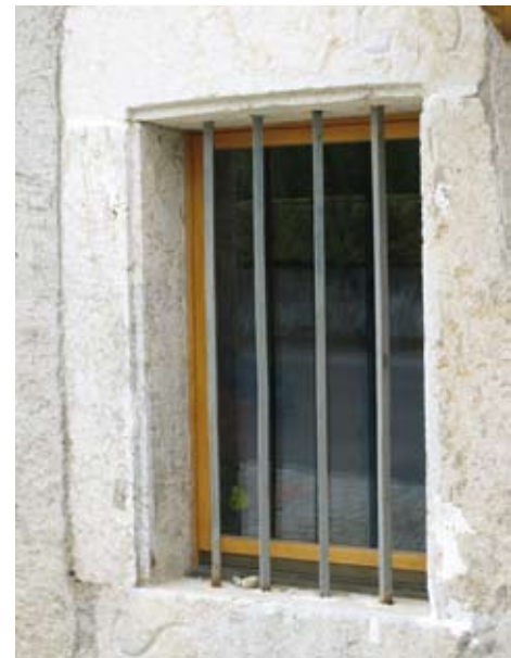
Usage insolite de vieilles bornes : elles servent maintenant de linteaux à cette fenêtre ! Cliché © J. P. Wisard – État de Genève.
