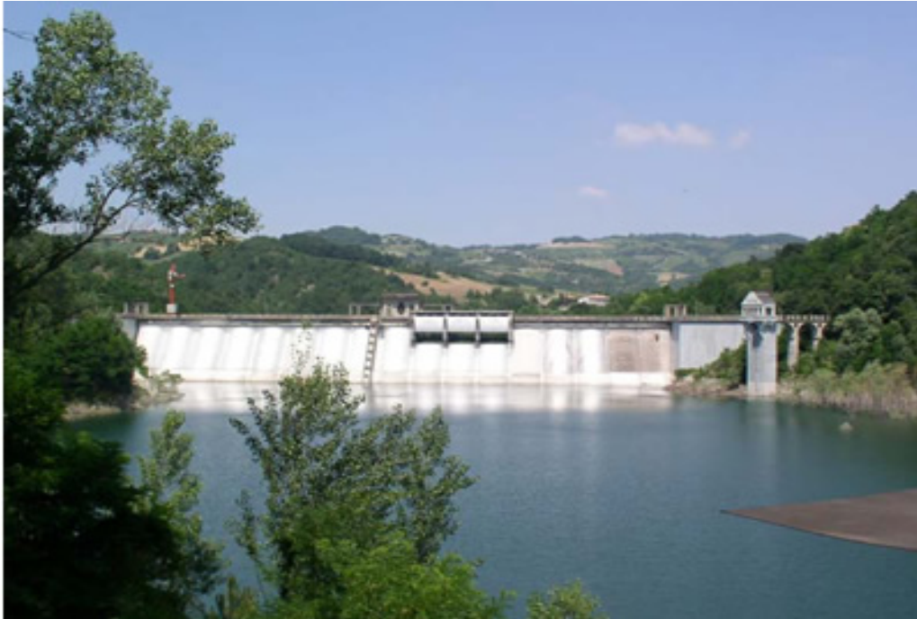
Figura 1.4 - La diga del Molato – vista da monte
