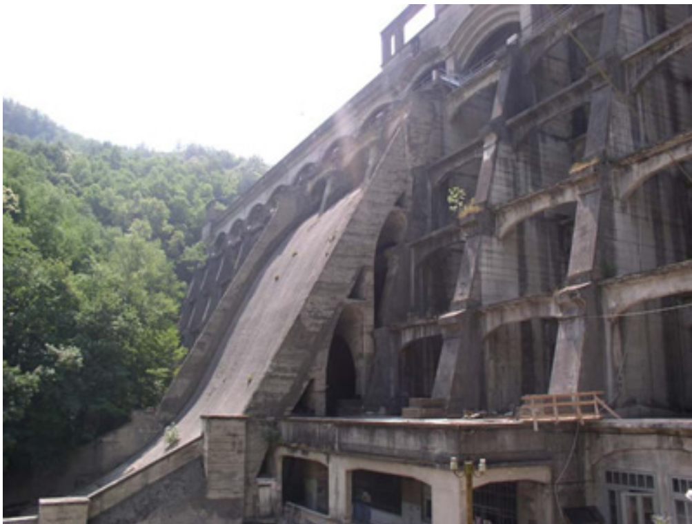
Figura 1.5 - La diga del Molato – vista da valle
