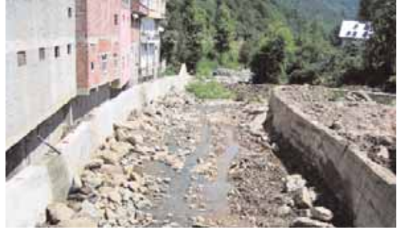
Giresun Piraziz Bozat Taşkın Koruma Tesisi: Tesis ile 1 beldenin taşkınlardan korunması sağlandı.
