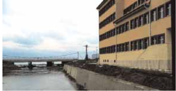
Giresun Merkez Büyükgüre Deresi Taşkın Koruma Tesisi: Tesis ile sınırları il merkezinde 1 mahallenin taşkınlardan korunması sağlandı.
