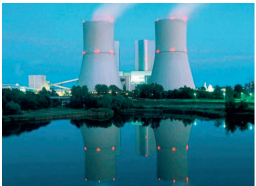
| Kraftwerk Lippendorf | Foto: Vattenfall Europe
