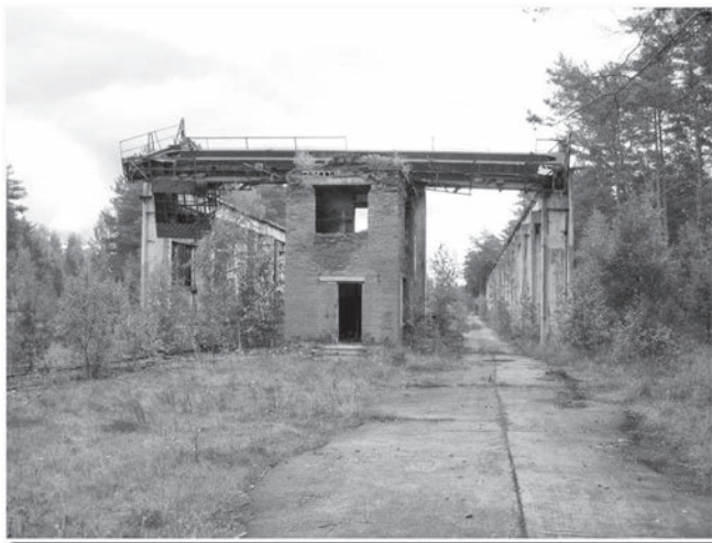
Перегрузочная площадка. Современное фото
