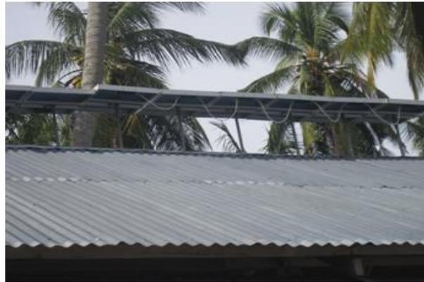
Gambar 3.13. Panel-panel surya yang dipasang di atas atap
