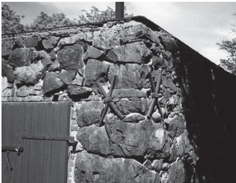
X-formade ankarslut användes under hela 1800-talet. Foto författarna, 2000.
