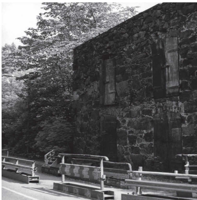
Oljeförrådets norra fasad. Foto författarna, 2000.
