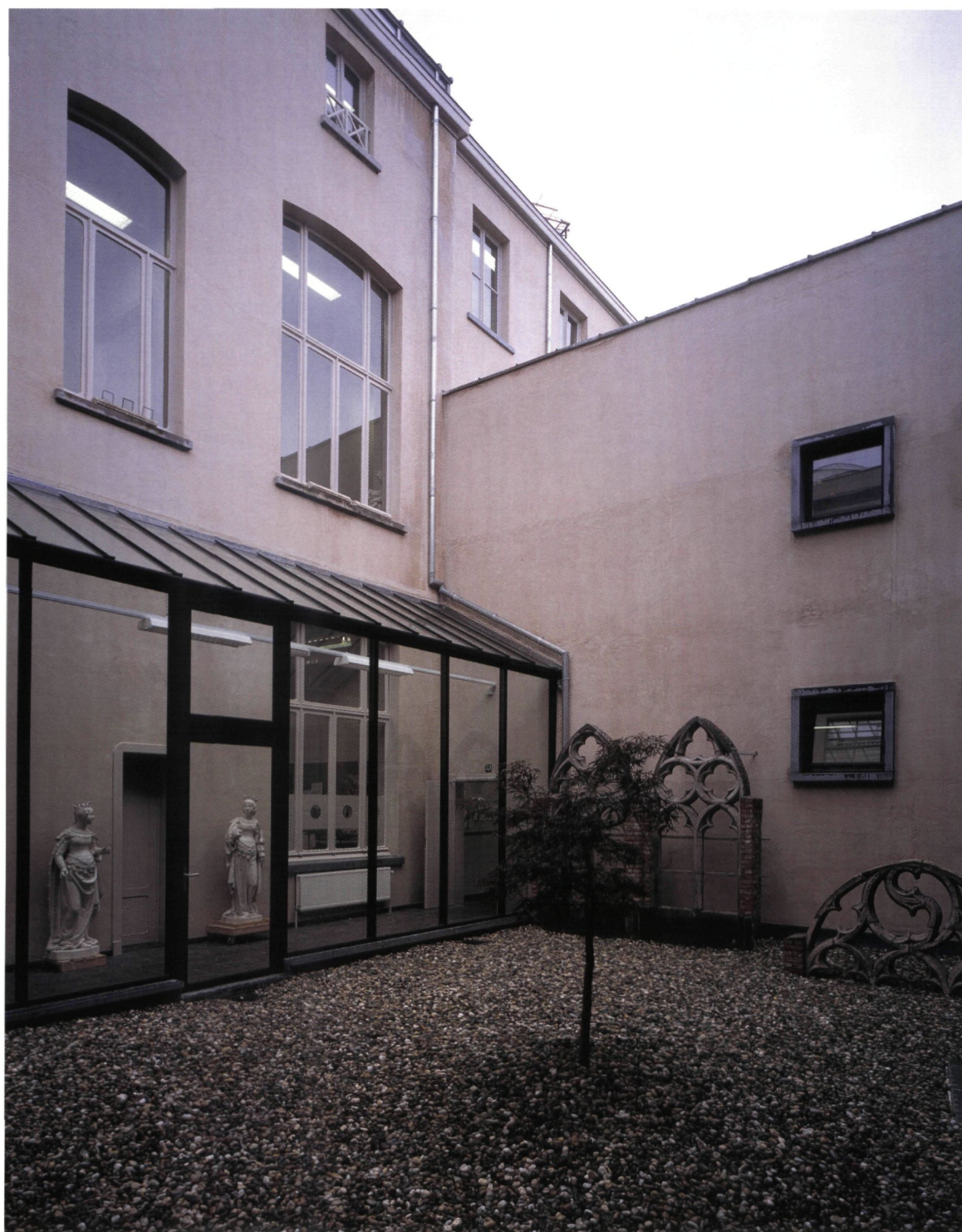
◀ Nieuwe doorgang tussen de binnenplaats van het Gesticht Arthur Van den Nest en het Bureel van Weldadigheid, uitgevoerd door ARCH-I naar ontwerp van architect Raymond De Braekeleer (Foto Oswald Pauwels)
