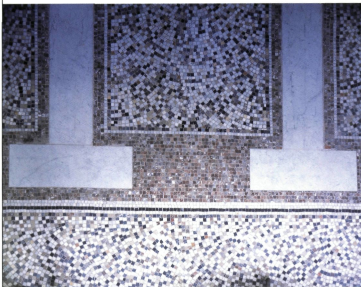
▲ Gerenoveerde vloer in het Gesticht Arthur Van den Nest (voorbouw links): op de plaats van de verwijderde luginomuren werd de vloerplaat in beton vervangen door witte marmer. Het mozaïekpatroon in witte, zwarte en roze-grijze marmer duidt precies de contouren aan van het oorspronkelijke kleedhokje (Foto Oswald Pauwels)
