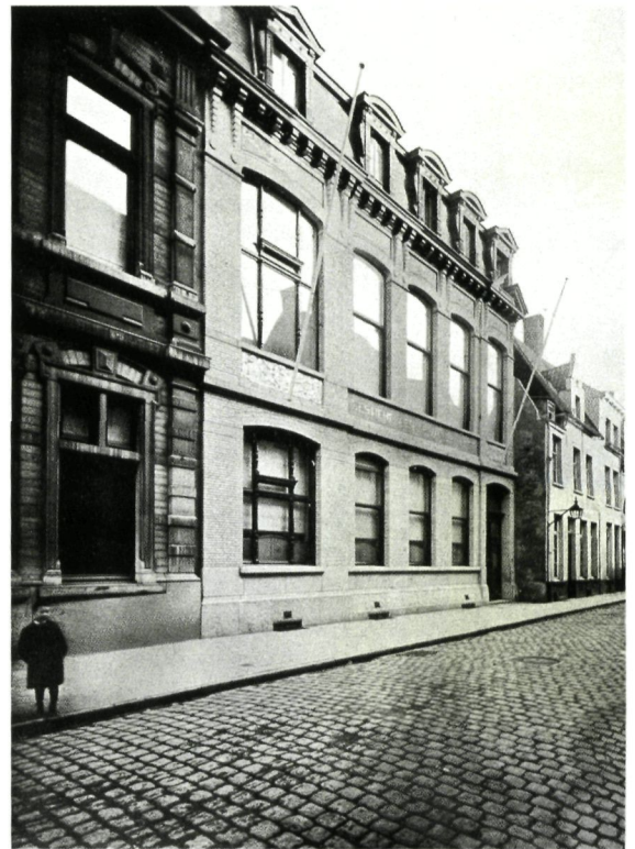
▲ Gevel van het Gesticht Arthur Van den Nest, met op de voorgrond de laatste travee van het Bureel van Weldadigheid (Foto uit Van der Ven, 1909)
