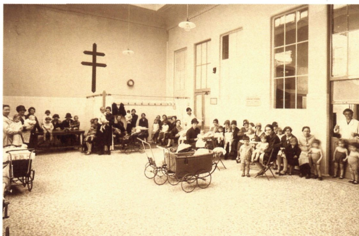
▲ Zicht op de polyvalente hal in het Gesticht Arthur Van den Nest voor de verbouwing van 1931: wachtzaal voor moeders en
