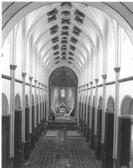
Werk in uitvoering: leggen van de vloer. Foto: Stadsarchief
