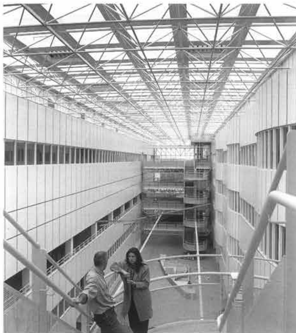
Serrehal AZM in aanbouw. Foto: AV Dienst AZM
