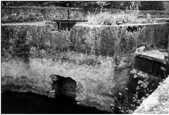
Canal y compuertas de los Altos Hornos de La Merced
