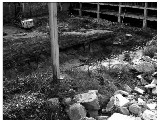
El dique de la segunda mitad del s. XIX, en la zona Norte de la plaza de las Farolas.
