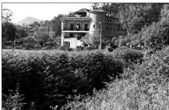
Casa de Entrambasaguas y restos canal de la ferrería.
