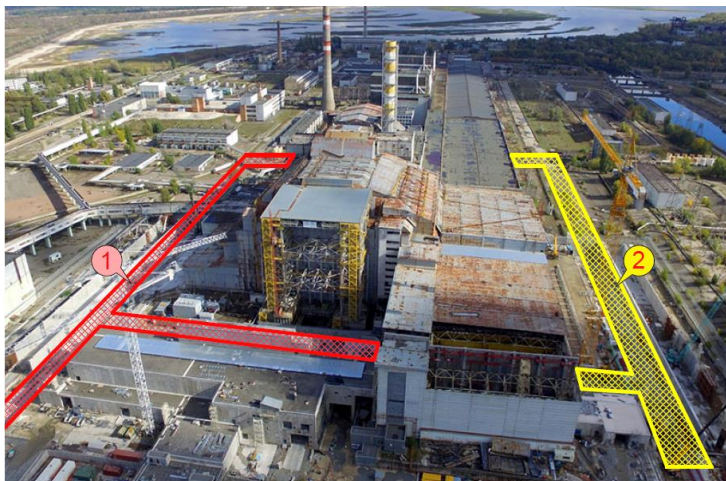
Рисунок 1. Об'єкт «Укриття»: 1 - північна стрічка фундаменту; 2 - південна стрічка фундаменту
