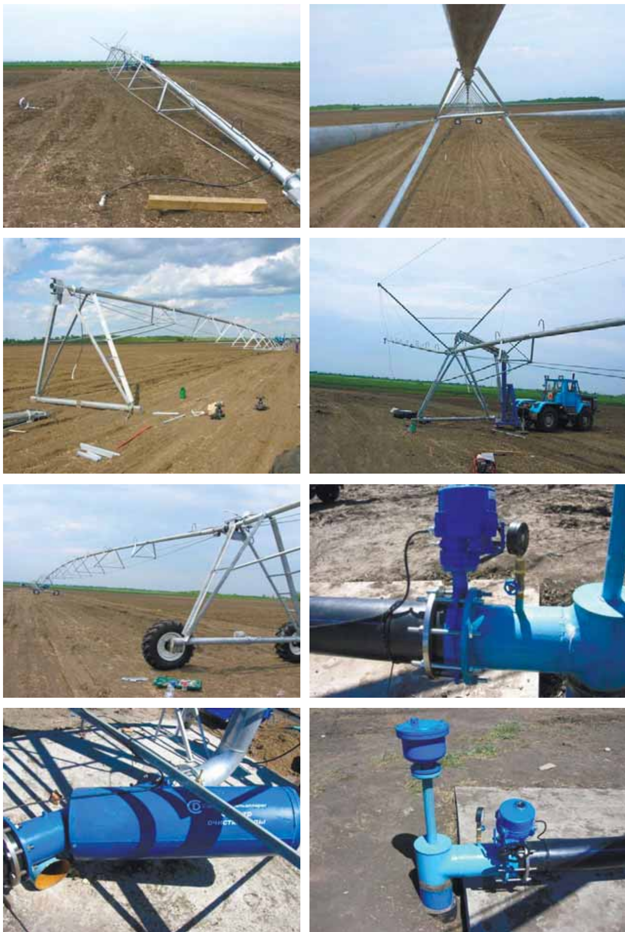
Рисунок 2.7 – Монтаж «Кубань-ЛК1М» (КАСКАД)
