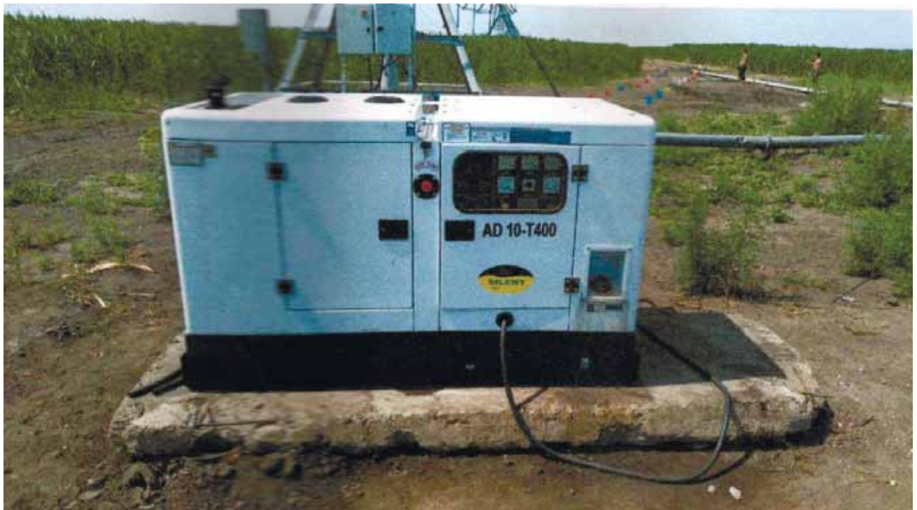
Рисунок 5.1 – Дизельный генераторный агрегат AD10-T400
