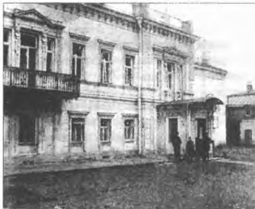
Здание в Леонтьевском переулке, где был совершен теракт
