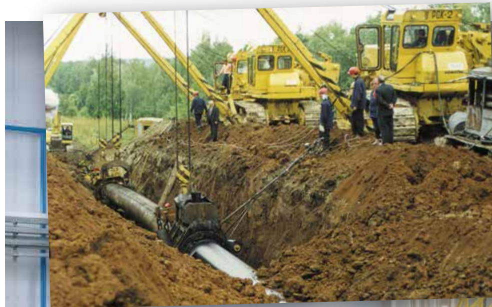
Капитальный ремонт с заменой изоляции нефтепровода Альметьевск – Куйбышев-1, 1997 год
