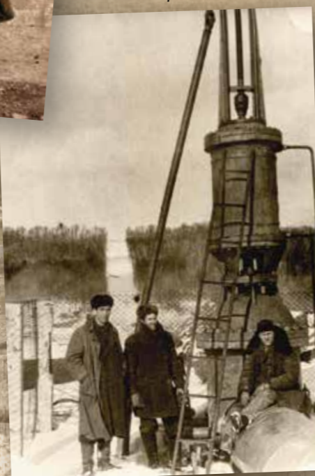
НПС «Ковали». Ремонтные работы на береговой задвижке
