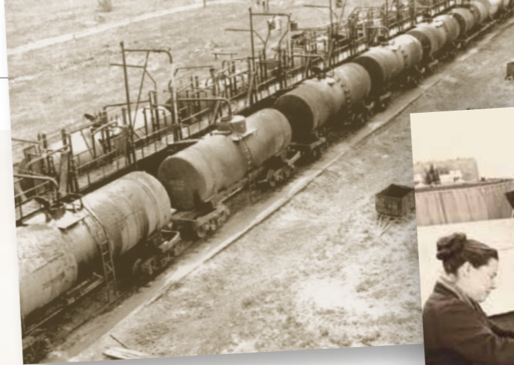
Наливная эстакада на станции Клявлино. Здесь нефть наливали в цистерны и отправляли по железной дороге, 1950-е годы
