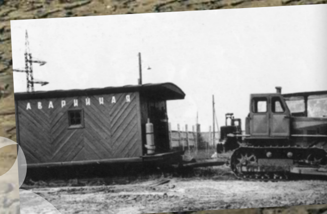
Из-за нехватки большегрузной техники до 1970-х годов приходилось использовать «аварийный поезд» – вагоны вывозили «по трубе» на тракторах
