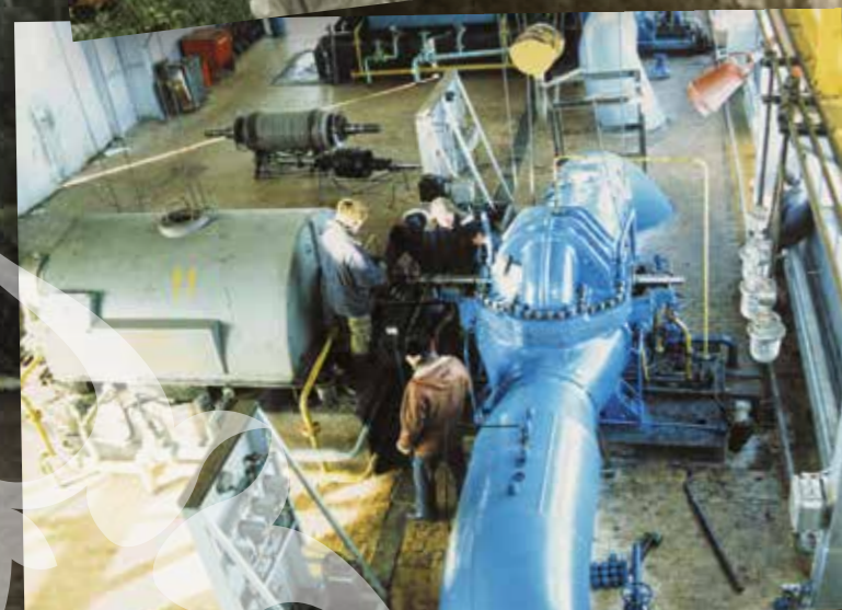
Центровка насосного агрегата в Пермском РНУ, 1996 год
