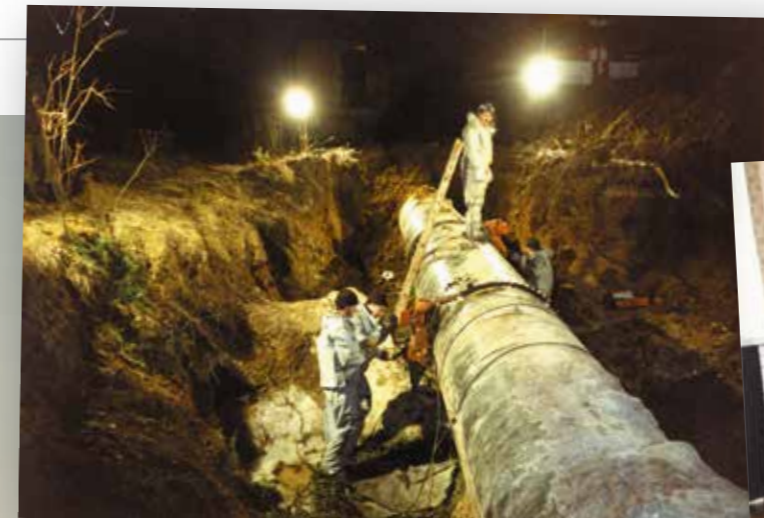
Бригада Пермского РНК на замене дефектного участка нефтепровода Сургут – Полоцк, 1995 год
