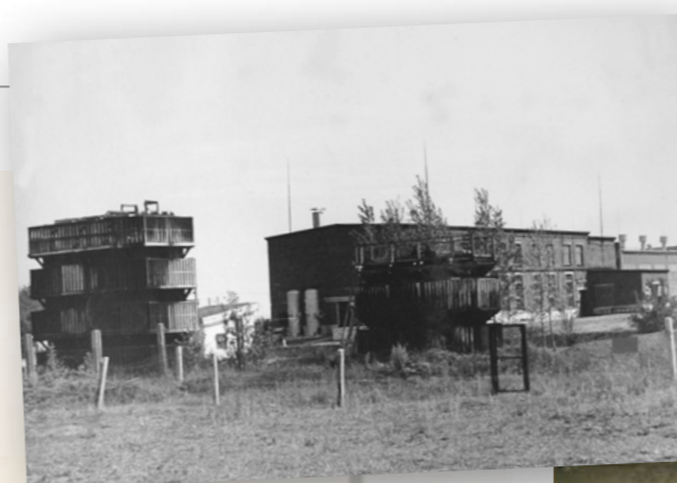
Здание нефтенасосной на НПС «Тиньговатово»
