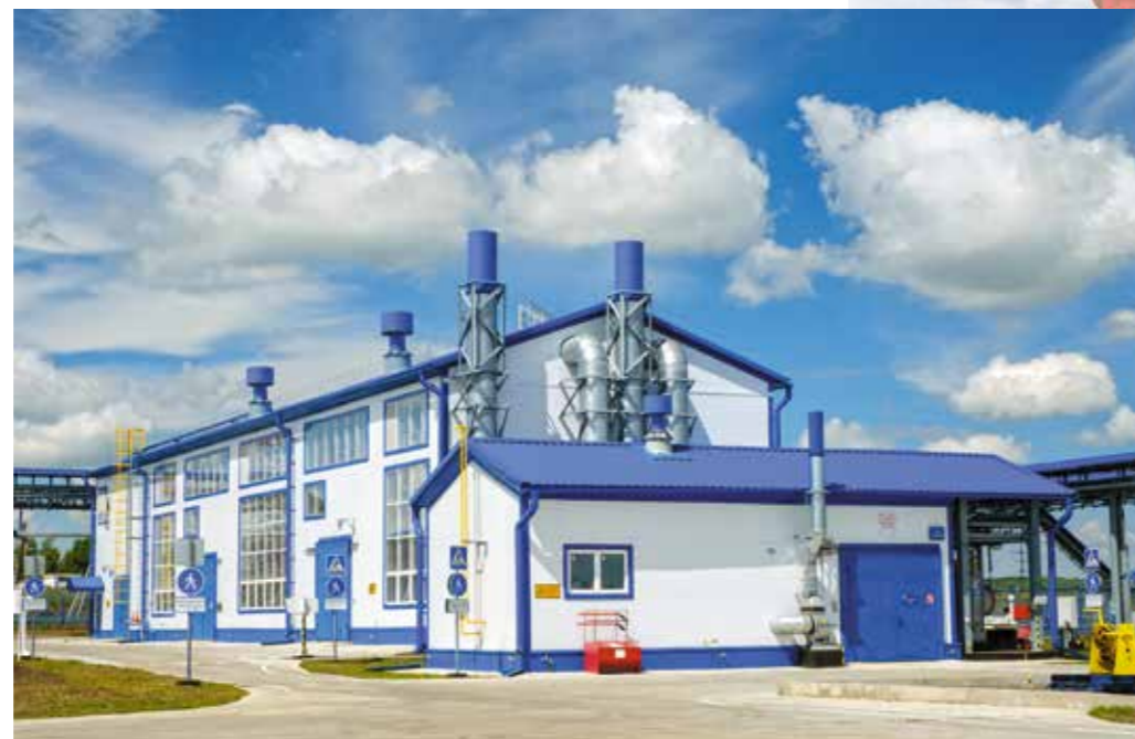
Магистральная насосная станция ППС «Михайловка-1»
