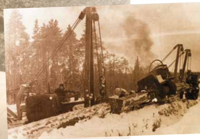
Строительство нефтепровода Уса – Ухта, 1973 год
