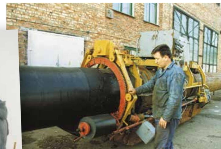
Испытание новой техники для ремонтно-строительных колонн ЦБПО, 1997 год
