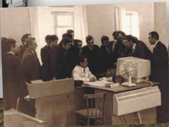
Испытания первых систем автоматики на НПС «Калейкино», 1975 год
