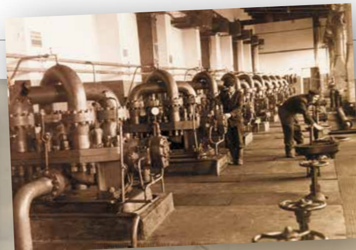
НПС «Ромашкино». Насосы 8НД-10х5 с электродвигателем АЗП-1600, 1964 год
