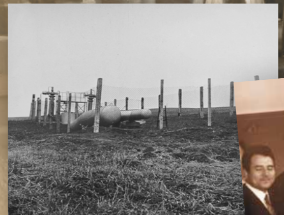
Камера приема скребка на реке Волге, НПЗ «Ковали», 1977 год
