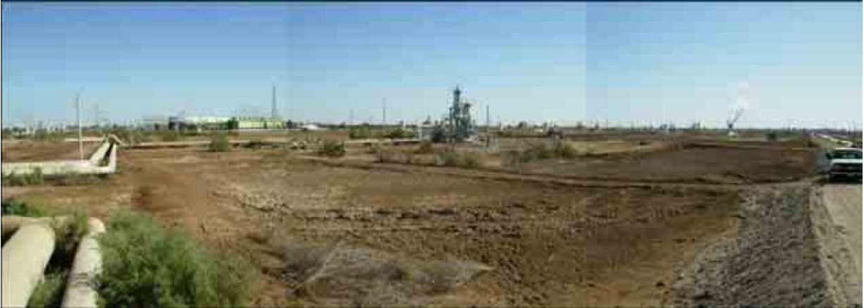
Figura IV.32. Panorámica del sitio propuesto para la instalación de la central geotermoeléctrica Cerro Prieto V
