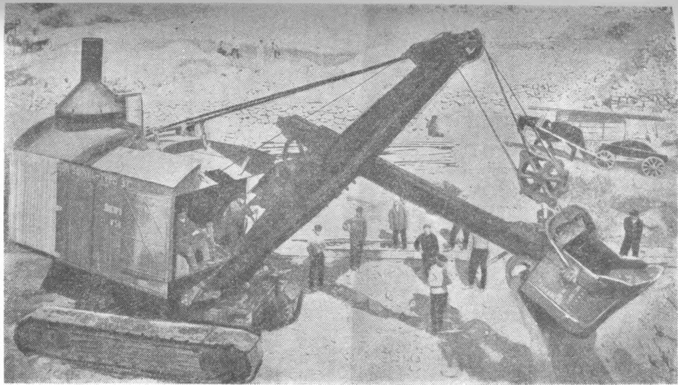
Один из первых, поступивших на Днепрострой, экскаваторов с ковшом емкостью 1,34 куб. метров, вынимает скалистый грунт.
