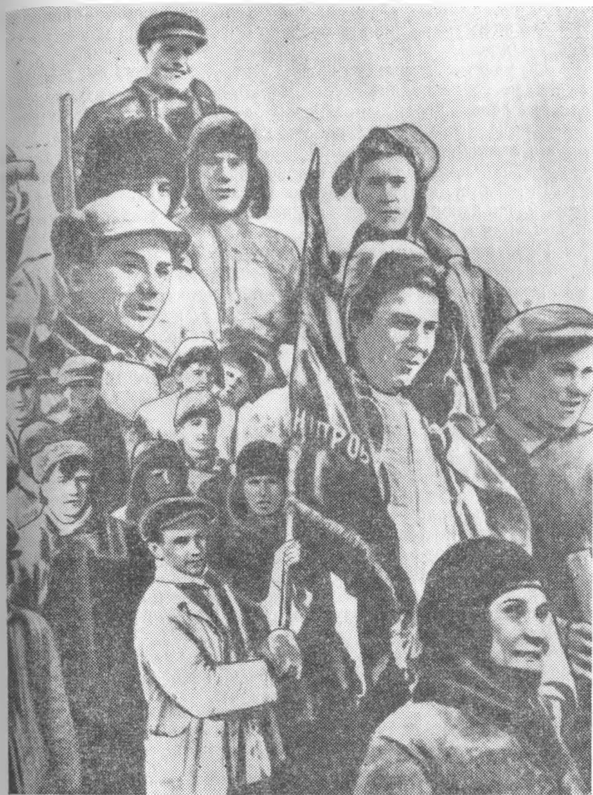
Одна из лучших ударных бригад бетонщиков Днепроостроя, возглавляемая бригадиром т. Ткаченко (в центре со знаменем).
