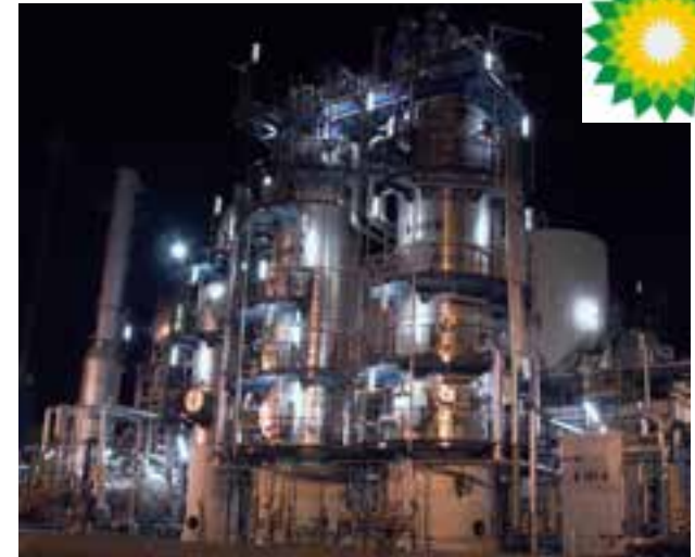
BITUROX® – BP LAVERA, Frankreich für Special Bitumens
