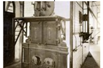
Котельня. Водотрубний котел с пароперегрівником
