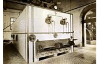
Котельня. Батарейний котел
