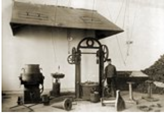
Механічні майстерні. Стале- та бронзоливарна. Піч Ріат
