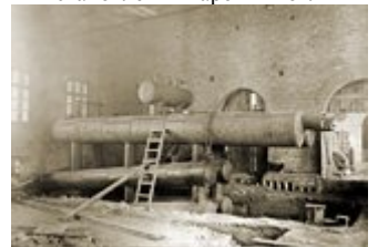
Встановлення батарейного котла
