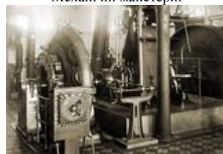
Машинне відділення. Машина Герліц потрійного розширення
