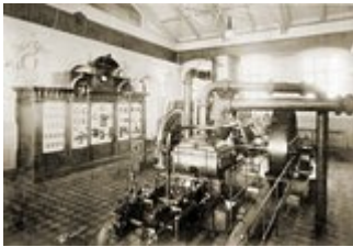
Машинне відділення. Холодильник змішування та родподільна дошка
