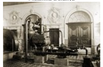
Машинне відділення. Холодильник змішування
