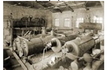
Встановлення парових котлів
