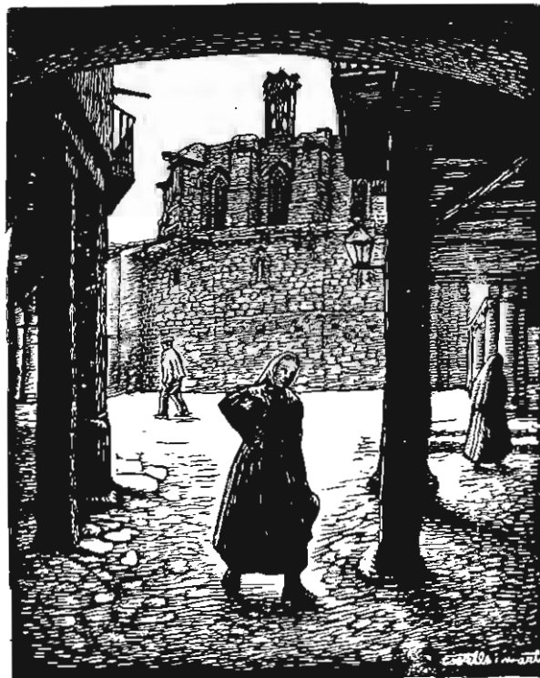
Sta. Coloma de Queralt Plaça de l'Església
