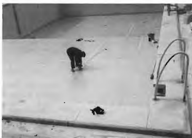
Procés de recobriment amb poliester d'una piscina
