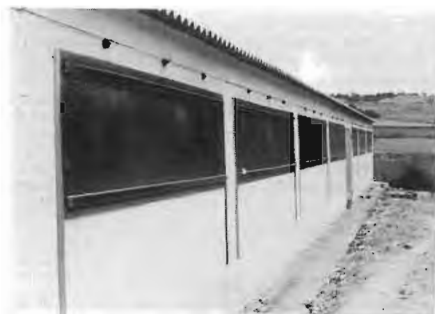
Finestres automàtiques de poliester d'una granja
