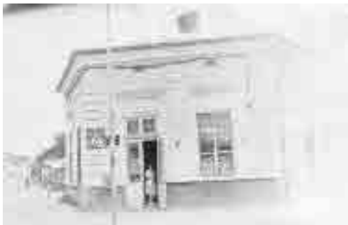
Fig. 350 Sediul provizoriu în 1988 (foto M. Cornaci)
