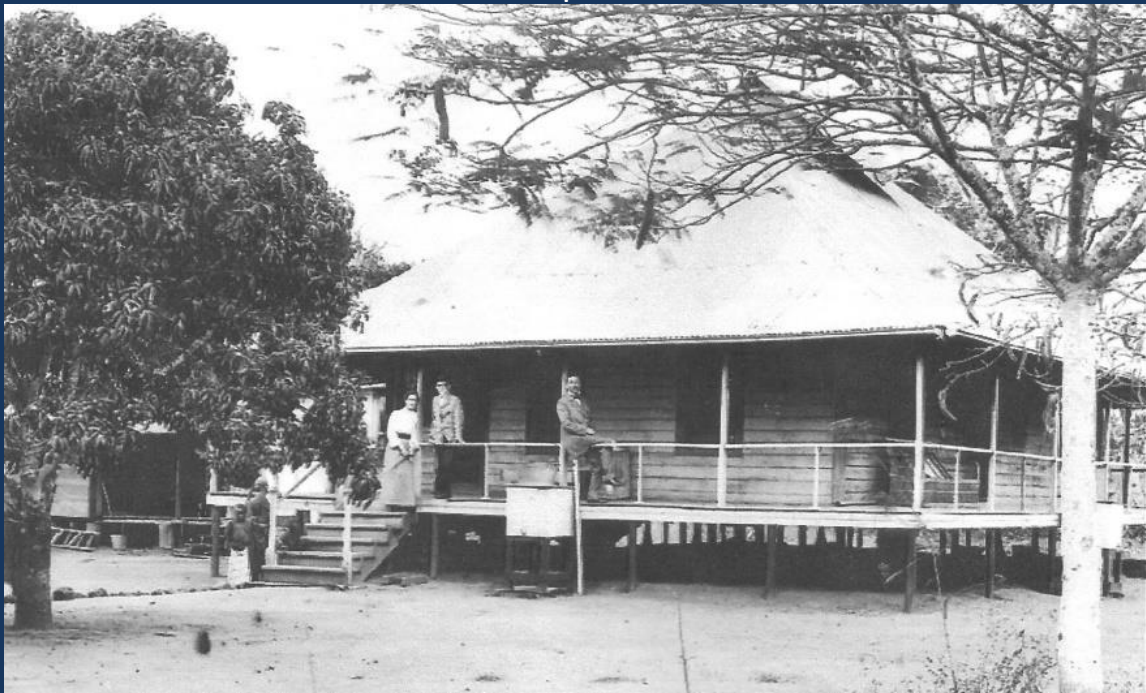
Mission protestante suédoise de Palabala. Bâtiment préfabriqué.
