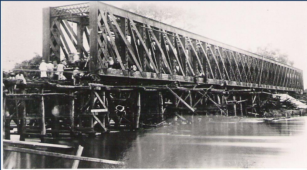
Le pont sur l'Inkisi. Construction et mise en place.
