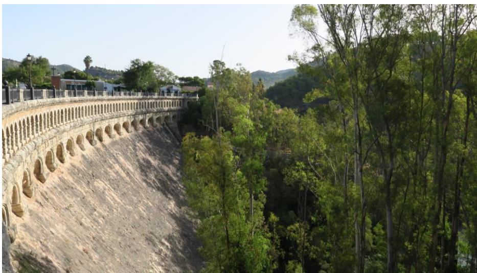
Figure 1.2.2: “Conde del Guadalhorce” Dam.
